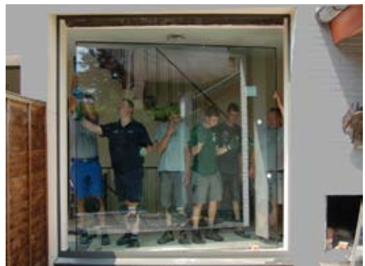
HR-beglazing vervangt het enkel glas
