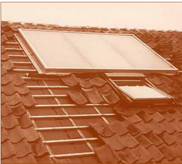
Geïntegreerd in een schuin dak
