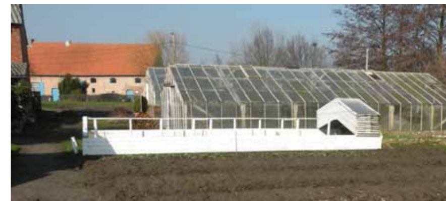
't Grom restaureert voor dit project de eenruiteren, voorlopers van de hedendaagse serre.
