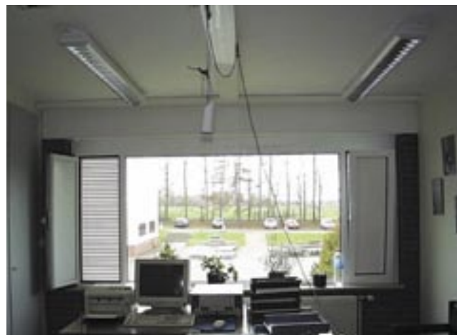
Fig. 39: Grote roosters voor nachtelijke ventilatie, manueel afsluitbaar met draai-kipraam met isolerend paneel (PROBE-gebouw).
