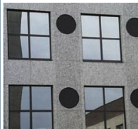
Fig. 36: Automatisch gestuurde openingen in de gevel zorgen voor de aanvoer van verse lucht tijdens de nacht om de gebouwmassa af te koelen. Elke gebruiker kan vanaf zijn pc de luiken openen en sluiten, ook overdag.
