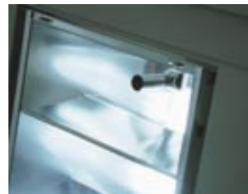
Fig. 66: Een kleine sensor in het verlichtingstoestel meet de luminantie op het werkopervlak en regelt het vermogen van het kunstlicht naar gelang van het beschikbare daglicht.
