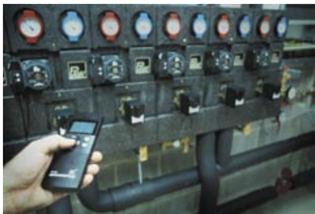
Fig. 21: Ook pompen zijn belangrijke energiegebruikers. Hier wordt de pompsnelheid via een frequentieregeling automatisch aangepast aan de warmtevraag in het netwerk. Zodra de comforttemperatuur in een kantoor wordt bereikt, schakelt de pomp voor dat circuit over op een lagere regeling. De pompen zijn via een afstandsbediening in te stellen.
