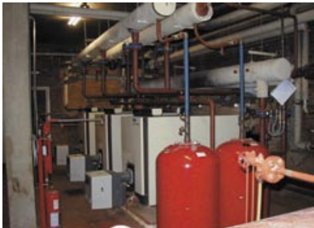
Fig. 20: De stookruimte met hoogrendementsketels van een goed geïsoleerd gebouw (IVEG, 2 condenserende gaswandketeltjes van 60 KW elk en een gesloten doorstroomgeiser voor warmwaterbereiding) en die van een renovatie (PROBE, Optimaz-stookolieketels), in cascade geschakeld.
