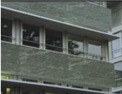
Fig. 29: Een zogenaamde 'lightshelf' vormt een structurele beschaduwing en zorgt door reflectie op de bovenzijde voor extra daglicht dieper in de kamer (links). Een structurele zonwering met alu-lamellen die nog wat diffuus licht doorlaten (rechts).
