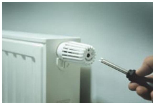
Fig. 22: Antivandaalthermostaten in de publiek toegankelijke ruimten zijn instelbaar met een speciale sleutel (IVEG).
