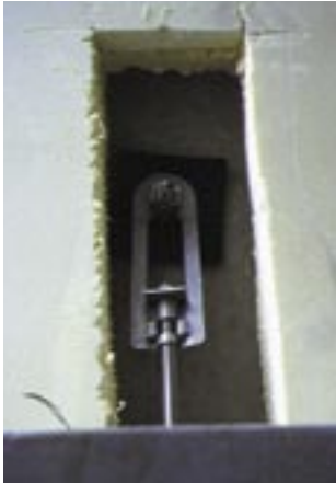
Fig. 14: De ankerpunten van deze zware gevelplaten in natuursteen vormen een koudebrug. In dit geval werden ze bevestigd met chemisch bevestigde pluggen met verminderde koudebrugwerking. Achteraf wordt de uitsnijding in de isolatieplaat opgeschuimd.
