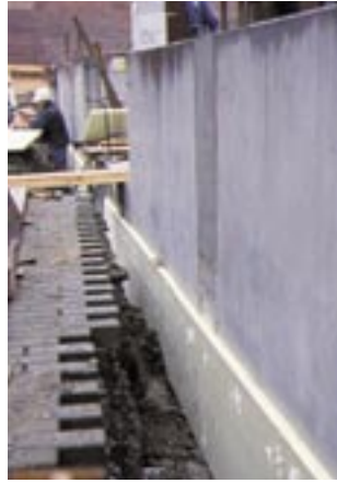
Fig. 14: De ankerpunten van deze zware gevelplaten in natuursteen vormen een koudebrug. In dit geval werden ze bevestigd met chemisch bevestigde pluggen met verminderde koudebrugwerking. Achteraf wordt de uitsnijding in de isolatieplaat opgeschuimd.
