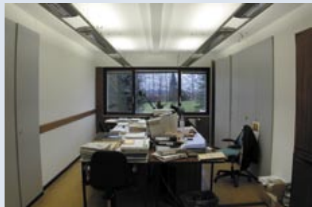
c) twee voorbeelden van direct-indirecte verlichting, allemaal met daglichtcompensatie.
