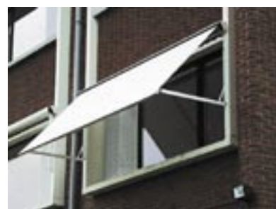
Sturing Zonweringen worden automatisch gestuurd door een weerstation afhankelijk van weer, regen en wind. In elk kantoor is ook een manuele regeling mogelijk.
