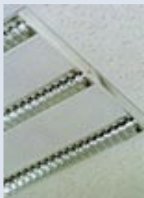
a) opbouw of inbouw met T5-lampen.
