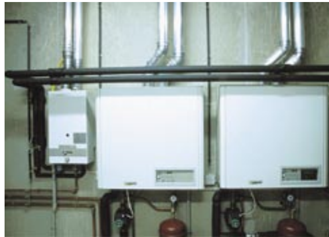
Fig. 20: De stookruimte met hoogrendementsketels van een goed geïsoleerd gebouw (IVEG, 2 condenserende gaswandketeltjes van 60 KW elk en een gesloten doorstroomgeiser voor warmwaterbereiding) en die van een renovatie (PROBE, Optimaz-stookolieketels), in cascade geschakeld.
