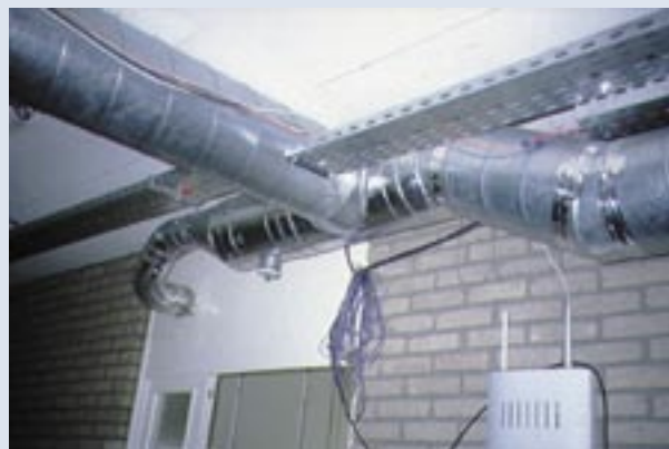
Fig. 50: Door opeenvolgende dichtingswerken kon het lekdebiet gereduceerd worden tot 102 m^3/h , dit is net klasse A van prEN13779.
