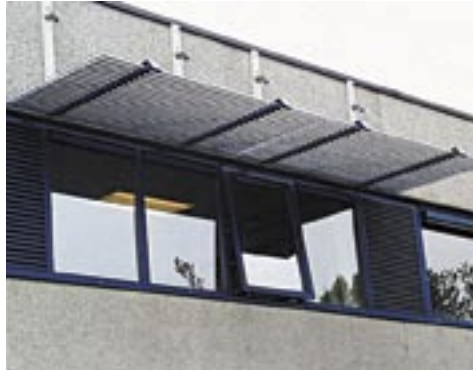
Fig. 29: Een zogenaamde 'lightshelf' vormt een structurele beschaduwing en zorgt door reflectie op de bovenzijde voor extra daglicht dieper in de kamer (links). Een structurele zonwering met alu-lamellen die nog wat diffuus licht doorlaten (rechts).
