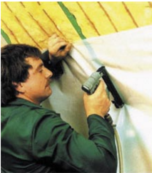
Fig. 16: Een luchtscherm is absoluut noodzakelijk bij luchtopen materialen.
