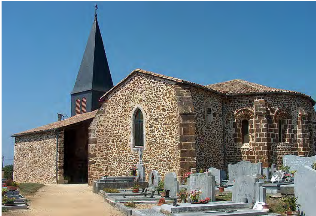
Figuur 56. 12e eeuwse romaans kerkje van Casteth in Bonnut, gebouwd met alios.
