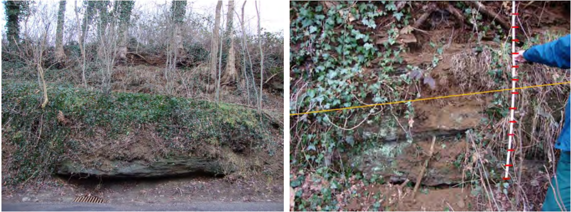
Figuur 52. Kapittelberg. Ontsluiting langs weg (let op dikke ijzerzandsteenbank onderaan) met rechts detail van de toplagen vlak onder het oppervlak (tussen boomwortels). Grens tussen schollen en ijzerzandsteen is gemarkeerd met gele lijn.
