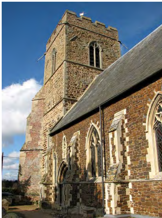
Figuur 60. De Holy Trinity kerk van Stow Bardolph, gebouwd in carrstone.
