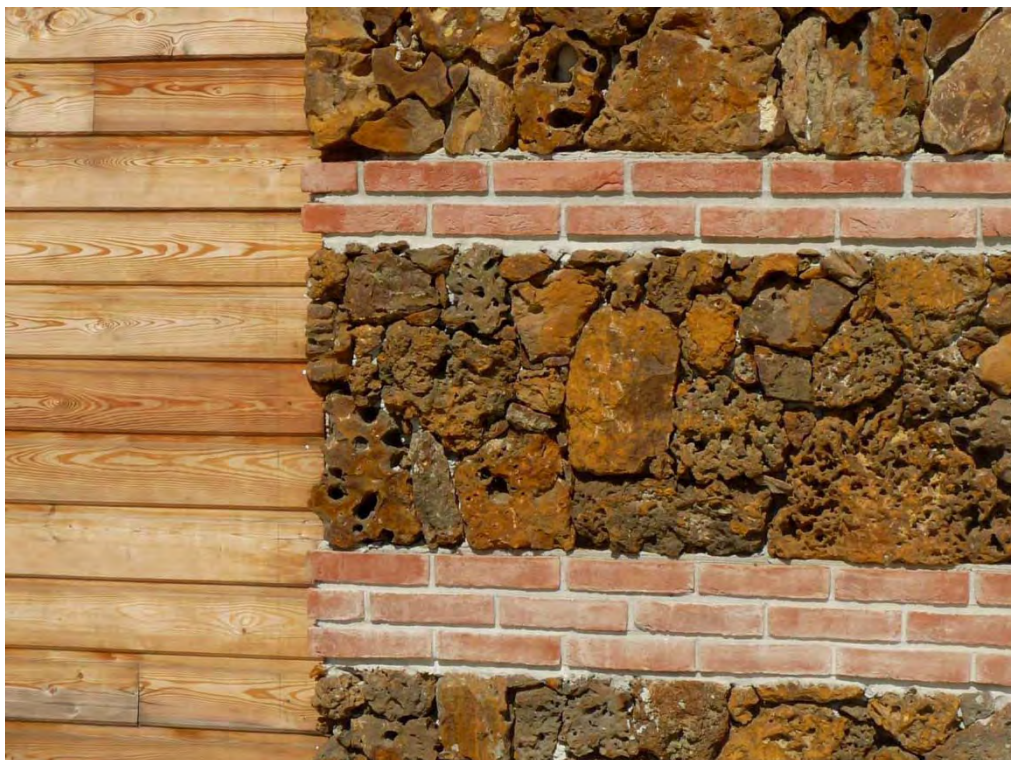
Figuur 57. Gebruik van "alios" in een moderne constructie, Aureilhan, Landes (F.)
