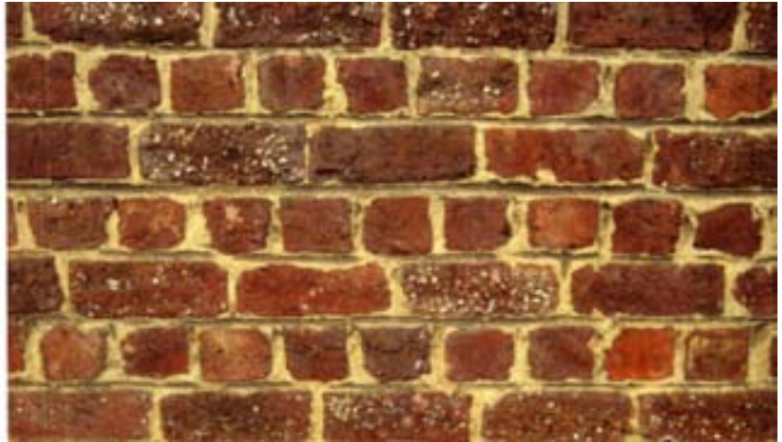
Afb. 2.25 SCHELDESTEEN Detail uit de wand van een 19e eeuwse hoefvetjete-Kerkhove waarin scheldesteen als parament werd gebruikt.
