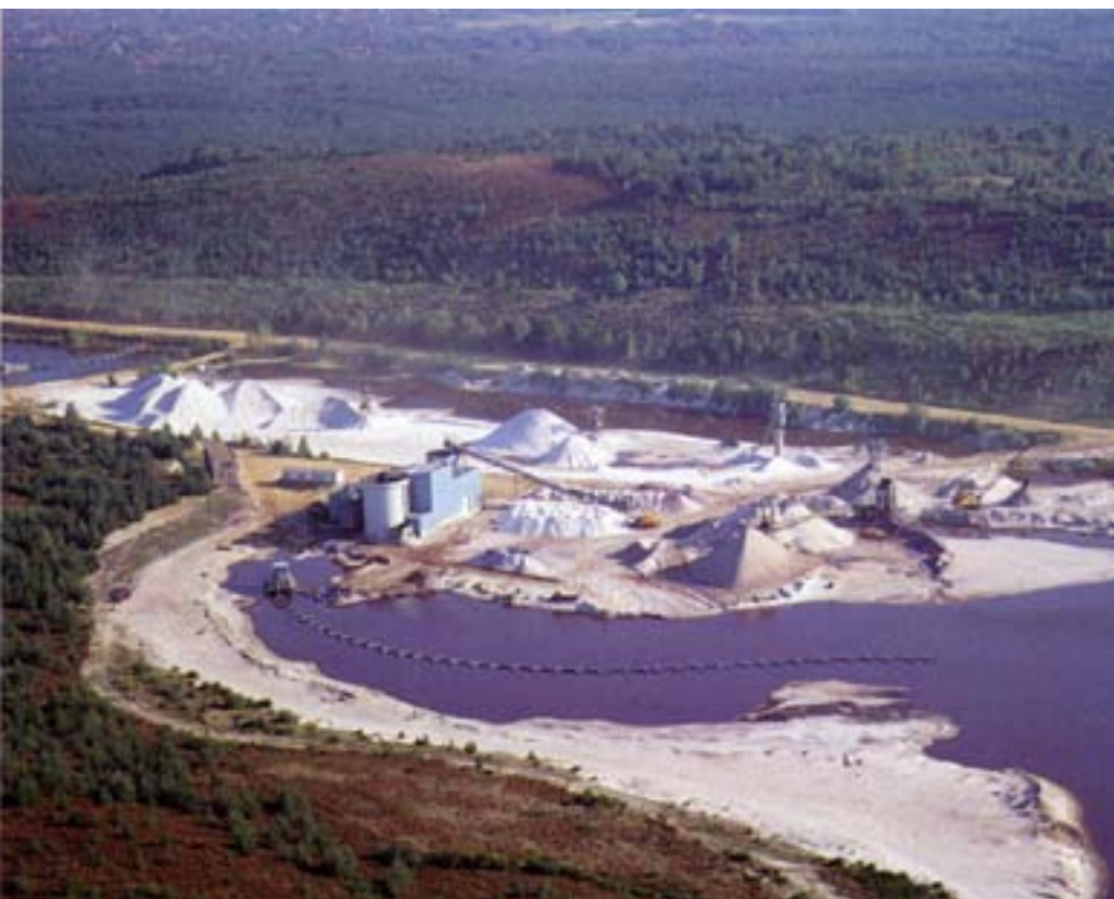
AFB. 7.8 VEREDELINGSINSTALLATIE VAN ZILVERZAND TE MAASMECHELEN
