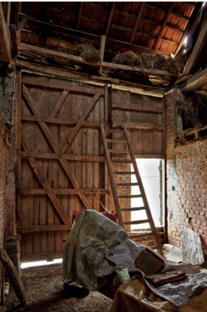
FIG. 23 – Schuurpoort (binnenzijde) van dwarsschuur op hoeve in Izenberge (Collectie Onroerend Erfgoed, Kris Vandevorst - 2015).
