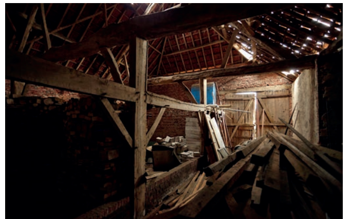
FIG. 26 – Interieur van langsschuur in Ravels (Collectie Onroerend Erfgoed, Kris Vandevorst - 2015).
