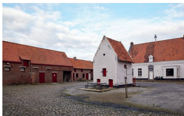
FIG. 46 – De duiventoren op de hoeve Roden Duifhuizen in Sint-Denijs (Collectie Onroerend Erfgoed, Kris Vandevorst - 2015).
