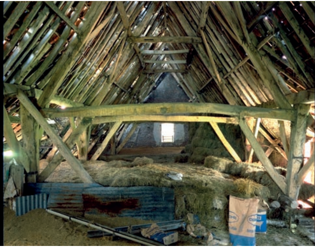
FIG. 21 – Het dakgebinte en het interieur met tasmuurtje van een schuur in Drongen (Collectie Onroerend Erfgoed).
