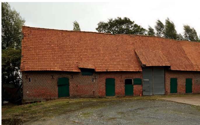
FIG. 19 - Dwarsschuur van de hoeve 't Hof van Izenberge in Izenberge (Collectie Onroerend Erfgoed, Kris Vandevorst - 2015).
