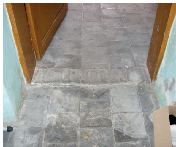
FIG. 12 – Natuurstenen vloer met bakstenen dorpel in boerenwoning in Vinkem (Collectie Clayhem Campagne, Keiem - 2005).
