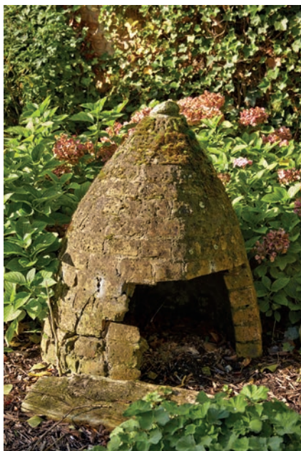
FIG. 41 – Het bakstenen konisch hondenhok op hoeve in Alveringem (Collectie Onroerend Erfgoed, Kris Vandevorst - 2015).
