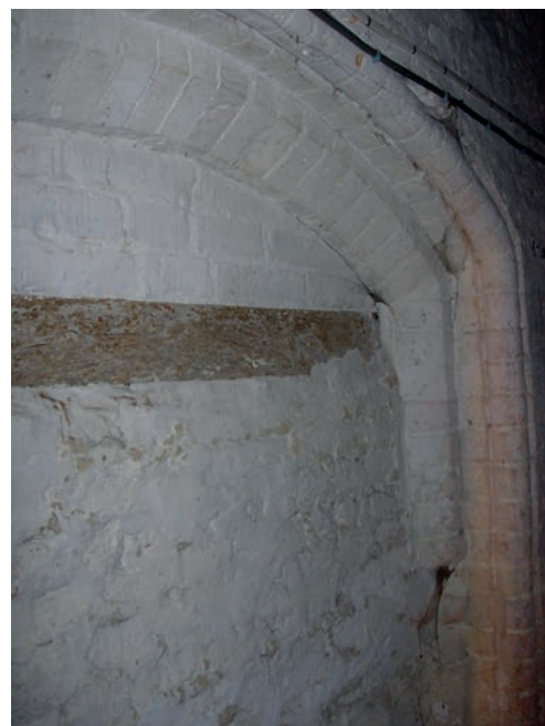
FIG. 99 – Korfboogvenster in de oude achtergevel van boerenwoning in Vinkem (Collectie Clayhem Campagne, Keiem).
