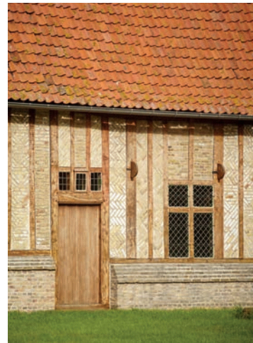
FIG. 16 – Het woonhuis in sierlijk baksteenmetselwerk van de hoeve Inghels in Leisele (Collectie Onroerend Erfgoed, Kris Vandevorst - 2015).
