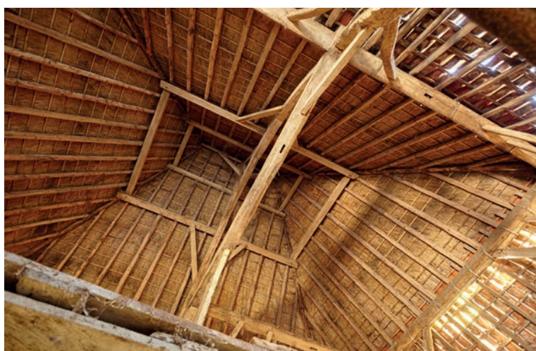
FIG. 30 – Dakconstructie van de bergschuur in Snaaskerke (Collectie Onroerend Erfgoed, Kris Vandevorst - 2015).
