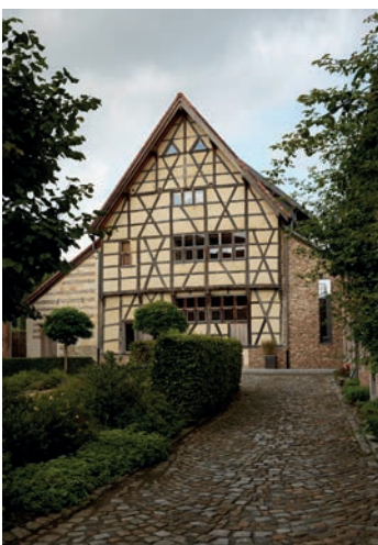
FIG. 3 - Het woonhuis van de hoeve Hof van Eggertingen in Millen (Langstraat 29) (Collectie Onroerend Erfgoed, Kris Vandevorst - 2015).
