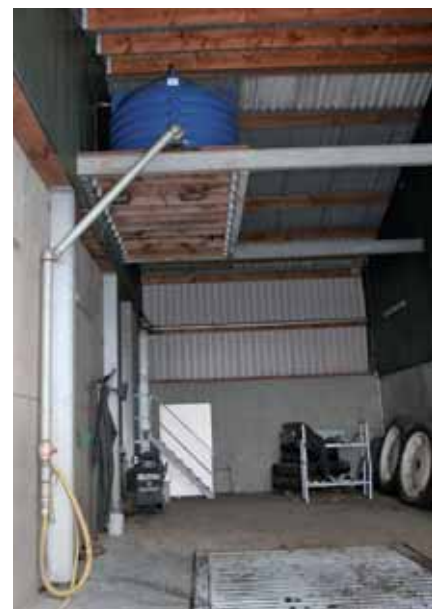
De spuitvulplaats op het bedrijf bevindt zich binnen in een loods.
