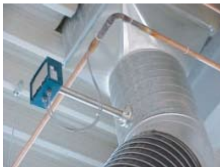
Figuur 25: Vochtigheidsvoeler op het uitlaatkanaal van de droger (bron: Habuco).
