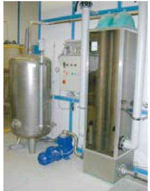
Figuur 11: Vertikaal opgestelde warmtewisselaar met doorvoerpomp, buffervat en controle-unit. Dit is een getordeerde pijpwarmtewisselaar. De gedraaide pijpen moeten vervuiling voorkomen (bron:JohnsonDiversey).
