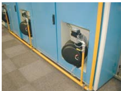
Figuur 28: Rechtstreekse aardgasverwarming op finisher (bron: Streitz).
