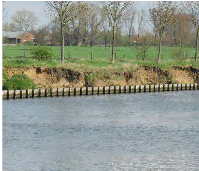
Foto 1: Vooroever opgebouwd uit palenrijen (links) en azobé-beschoeiing (rechts)
