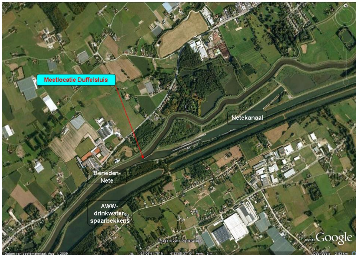
Figuur 148 - Beneden-Nete te Duffelsluis : meetlocatie
