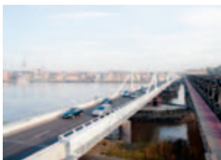
De nieuwe Scheldebrug in Temse
