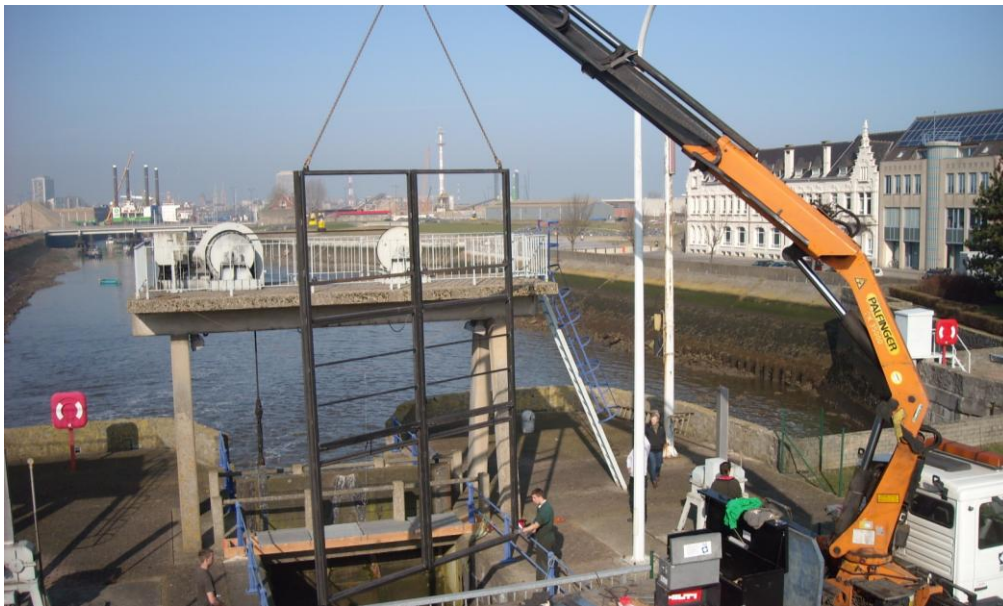
Fig. 10. Plaatsing van het kader achter de sluisdeur. Hierin schuiven twee fuiken met daarboven voor elke fuik 1 scherm.
