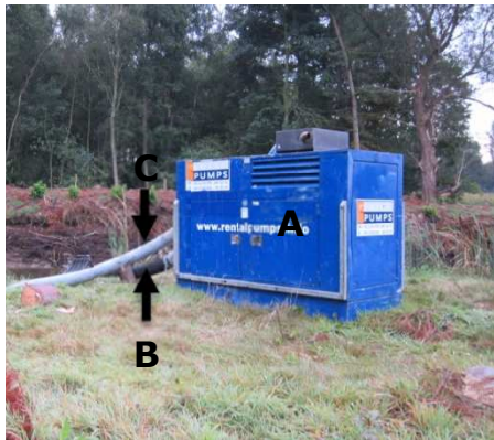
Figuur 69: (A) Vuilwaterpomp met piekdebiet van 400 m 3 /u gebruikt om 'het Fort' Leeg te pompen, (B) aanvoerslang met zuigkorf en (C) Afvoerslang.
