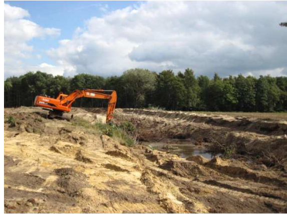
Figuur 79: 'Het Fort' gedurende de graafwerken.
