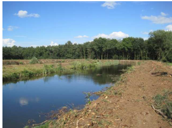
Figuur 76: 'Het Fort' na de kap werkzaamheden.
