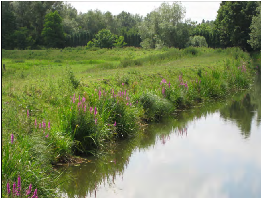
Foto 9. Voorbeplante koksvezelmatten stroomafwaarts de Heirbaanbrug (RO) met een 4/4 helling
