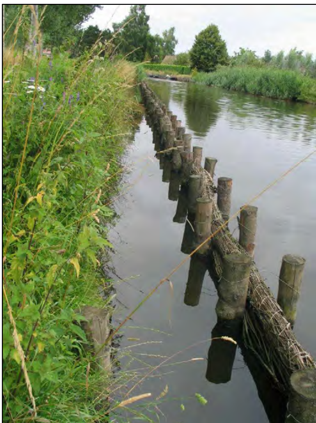
Foto 7. Constructie op het traject Coudenbormbrug-kanaal van Stekene (LO). De ruimte die tussen de oever en de rivier gelaten werd vormt een luwe zone met verminderde golfslag, waar watervogels kunnen schuilen en vissen kunnen paaïen
