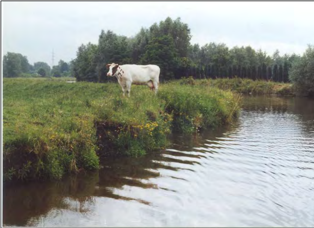
Foto 2. Afkalvingen op de oevers stroomafwaarts de Heirbaanbrug (2000)
