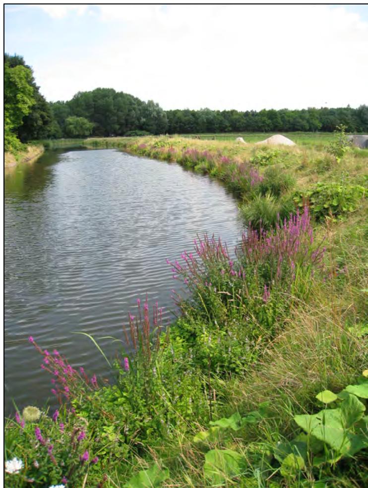
Foto 10. Voorbeplante koksvezelmatten stroomopwaarts de Heirbaanbrug (LO) met een 8/4 helling
