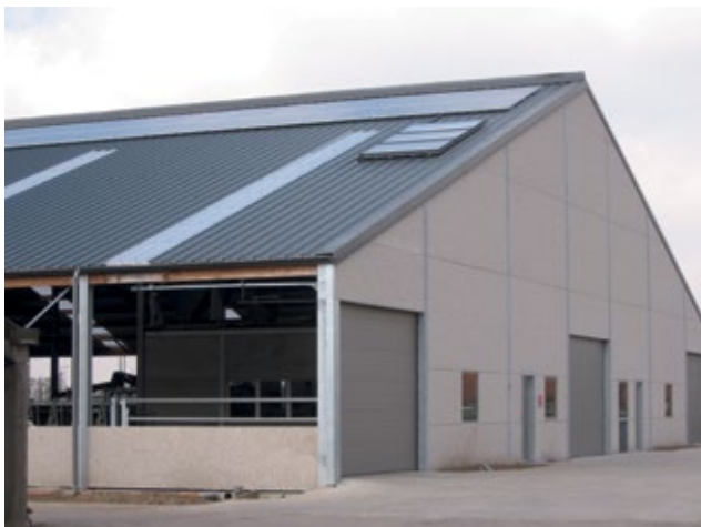
Zonneboiler (Bron Innovatiesteunpunt)
