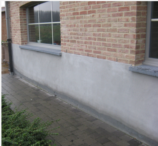
Figuur 10: Regelmatig bespatten van de muurvoet door regenwater of smeltwater (links) kan resulteren in een zichtbaar vochtfront in de muur (rechts).
