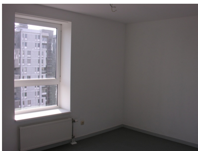
Figuur 45: Voorbeeld van de plaatsing van verwarmingsbuizen aan de warme kant van de isolatie.
