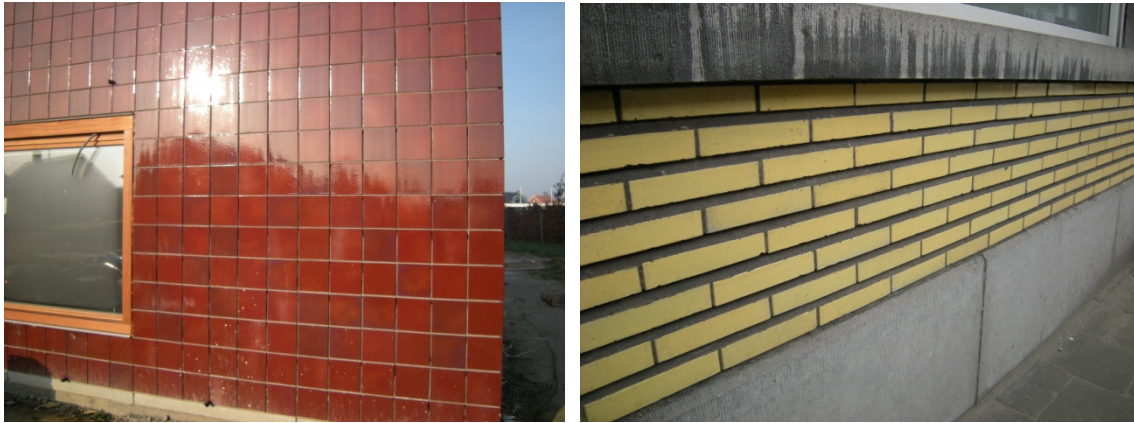
Figuur 20: Gevelafwerking die bestaat uit keramische tegels (links) en geglazuurde gevelstenen (rechts)
