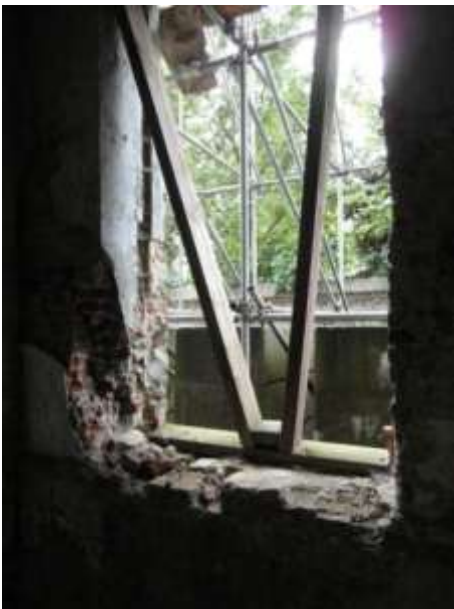
Uitgebroken schrijnwerk
