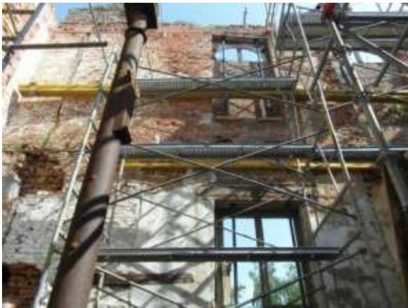
Toestand na het nemen van de opgelegde consolidatiemaatregelen (stutting/schoringswerken)
