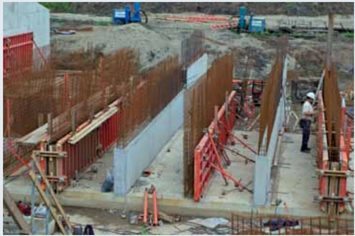
Afbeelding 7.7. Betonning van de wanden
