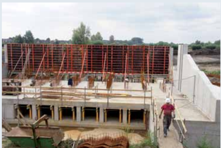
Afbeelding 7.9. Bekisting en wapening van de bovenbouw
