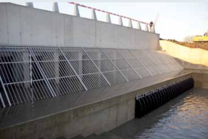
Afbeelding 7.10. Installatie van de randinfrastructuur
