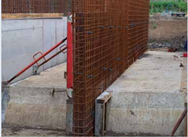
Afbeelding 7.5. Bekisting en wapening van de wanden
