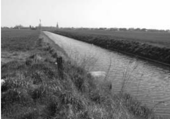
Foto 7. Zicht op de Nieuwe gracht, die instaat voor een groot deel van de afwatering in de Buitenmoeren. De oevers werden verstevigd met betonnen doorgroeiplateau om de passage van hoge debieten toe te kunnen laten. De hervestiging van oevervegetatie blijkt zeer moeizaam te verlopen.
