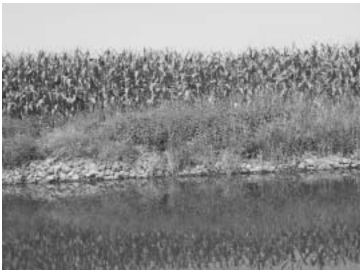
Foto 18. De schanskorven in het bovenpand van de Bergenvaart zijn op veel plaatsen weinig begroeid. De steile oevers zijn hiervoor deels verantwoordelijk, maar er wordt ook tot dicht bij de oever geboerd, wat resulteert in mest- en pesticidenuitspoeling met een sterk verruigde vegetatie (met veel brandnetel) tot gevolg.
