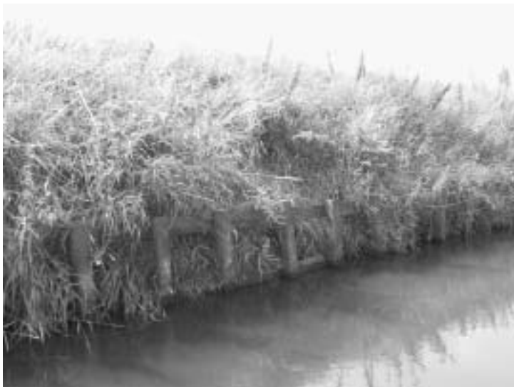
Foto 24. In 1980-1981 werden bepaalde delen verstevigd door middel van perkoenpalen met azobematten. Ook deze verdediging laat een relatief rijke oeverbegroeiing toe.
