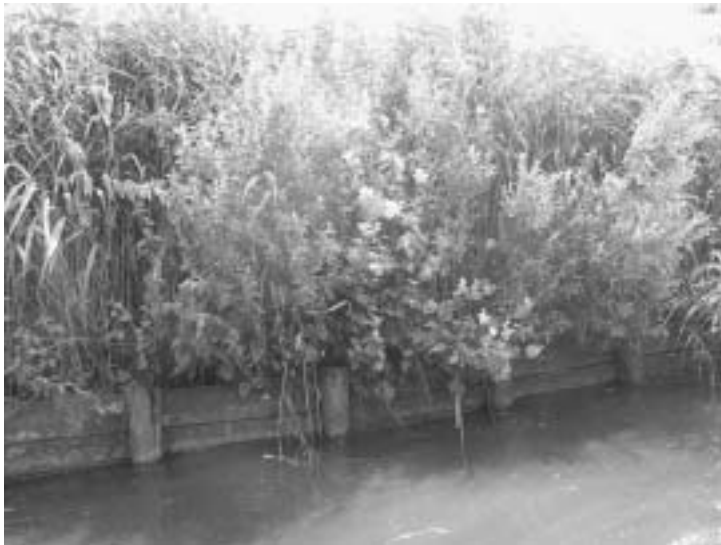
Foto 23. In het benedenpand van de Bergenvaart vinden we vooral oude kantanjehouten beschoeiingen terug. De doorlaatbaarheid van het hout resulteert in een relatief rijke oevervegetatie. Door de afscheiding van water en oever door het hout zijn hier echter geen paaiplassen voor vis aanwezig.
