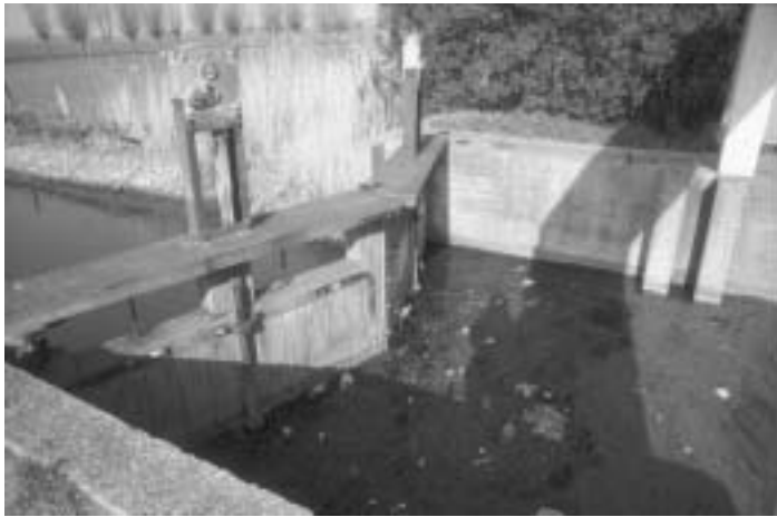
Foto 10. De stuw op de Bergenvaart te Veurne. Het pand links behoort tot de Bergenvaart (zomerpeil 2,44 m TAW, winterpeil 2,34 m TAW); het pand rechts behoort tot het kanaal Nieuwpoort-Duinkerke en heeft een streefpeil van 2,43 m TAW.
