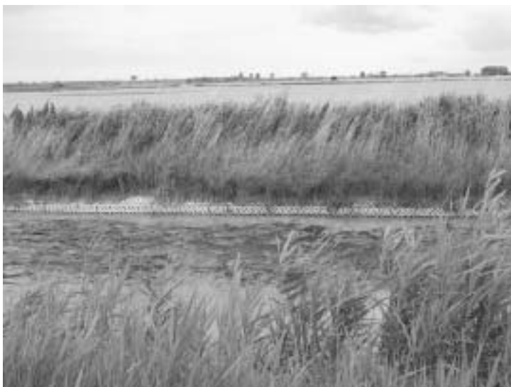
Foto 30. Een oever van de Ringsloot, verdedigd met doorgroeitegels. Ook hier verloopt de vegetatieontwikkeling niet vlot: ter hoogte van de waterlijn groeit bijna niets; hogerop het talud groeien vooral grassen.
