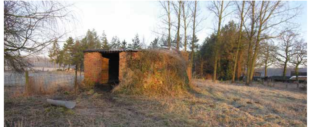
FIG. 2 Bouwkundig erfgoed met een industriële-archeologische waarde: de ruïne van een panoven in Schulen (Herk-de-Stad), de laatste tastbare getuige van de vroegere pannproductie in de streek ( https://inventaris.onroenderfgoed.be/dibe/relict/206922 ).
