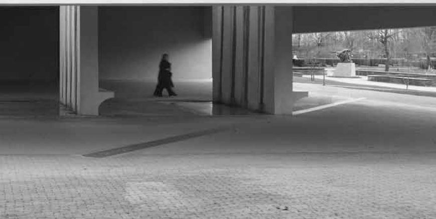
Het ceremoniegebouw van crematorium Heimolen in Sint-Niklaas, door Claus en Kaan architecten, 2008.
