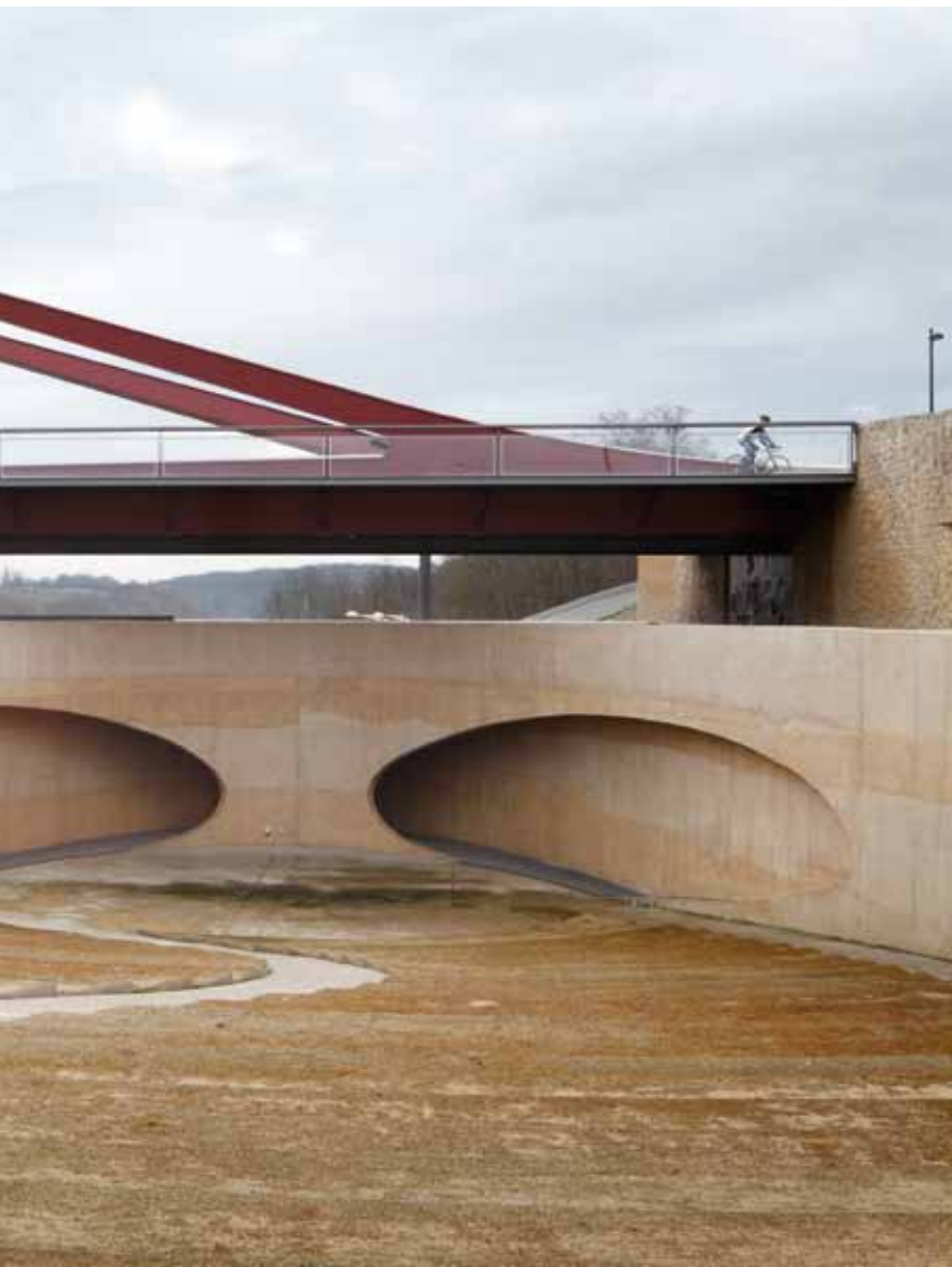
0229 Brug over het Albertkanaal, Vroenhoven, Ney & Partners, 2011
