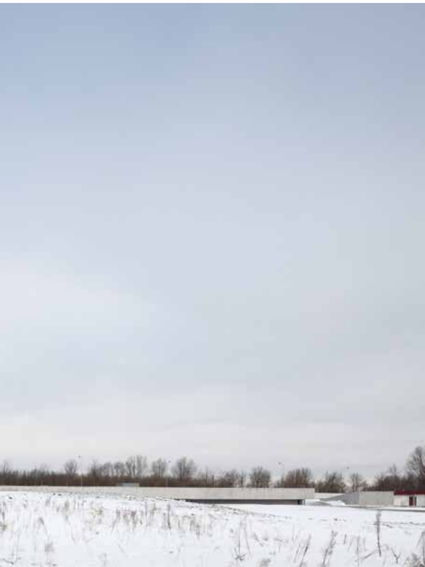
0908 Crematorium Uitzicht, Kortrijk, Souto de Moura Arquitectos i.s.m. SumProject, 2011
