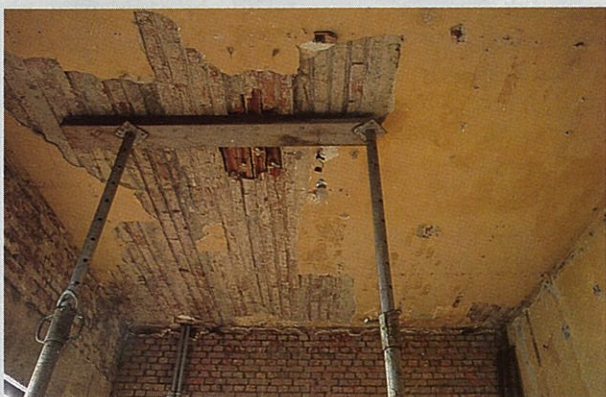
De ontmanteling in de kinderslaapkamer bracht de oorspronkelijke oker-kleur aan het licht (foto P. Robyn)
