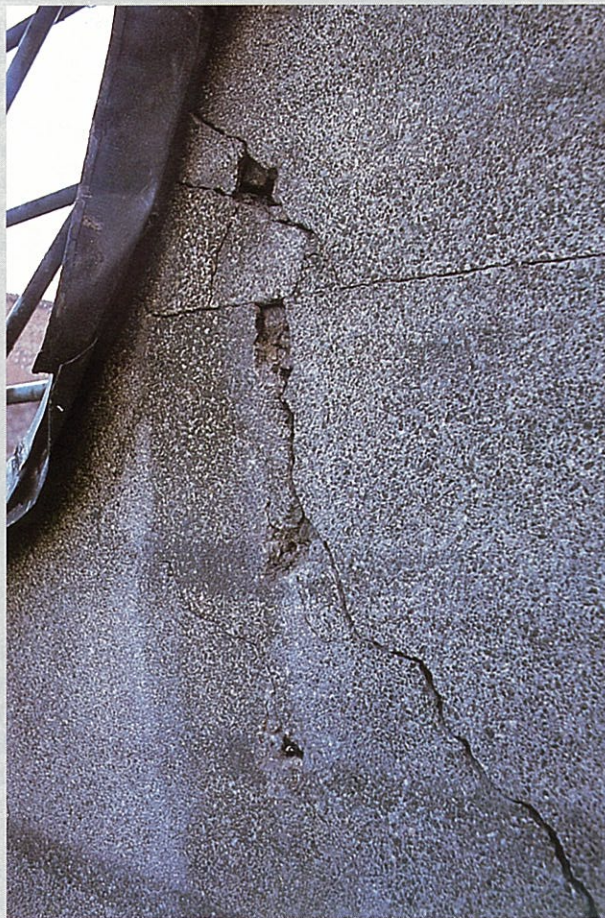
Detail van de 'Granilis'-bezetting met aanzetvoeg van bij de bouw en barsten (foto P. Robyn)
