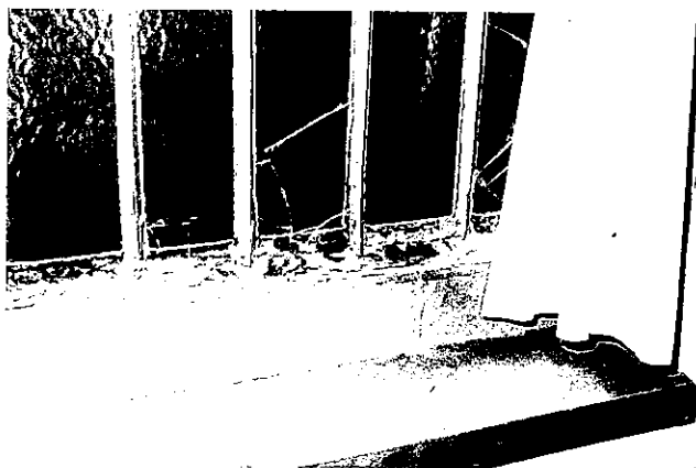
De betimmering met asbestcementplaten in de kinderslaapkamer (foto G. Baines)
