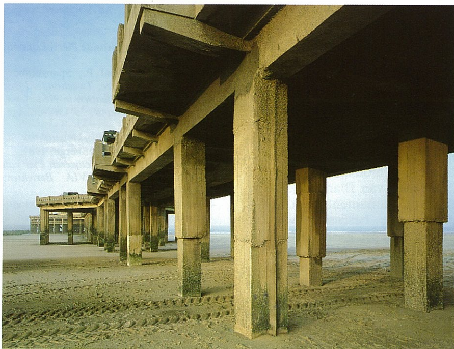
Een aantal betonnen steunpijlers werden reeds hersteld (foto G. Charlier)
