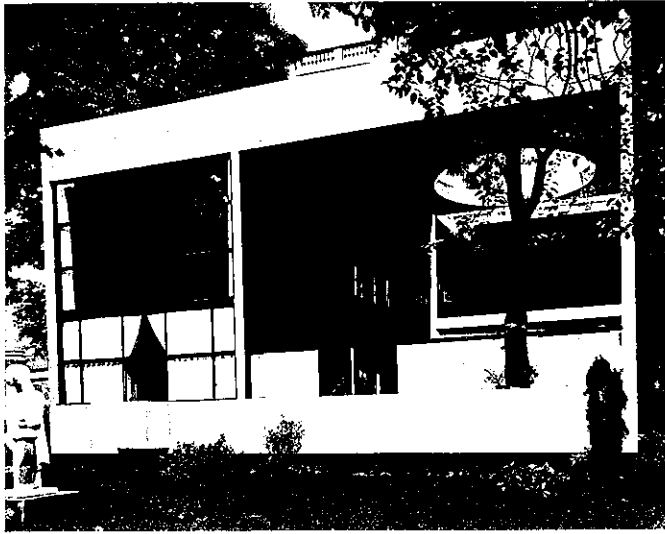
Het 'Pavillon de l'Esprit Nouveau' (1925) in Parijs (uit 'Œuvre complète, 1910-1929')
