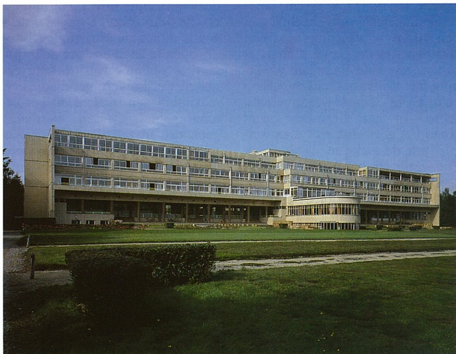
Zuidoostelijke gevel van de ziekenvleugel met op het gelijkvloers de open kuurgalerij, op de verdiepingen de ziekenkamers. Een beglaasde rotonde onderbreekt het strakke horizontale ritme (foto D. Stengée)
