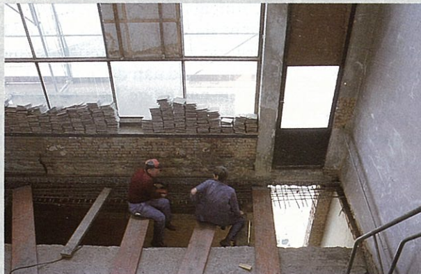
De werken ter verbetering van de stabiliteit van het balkon (foto P. Robyn)
