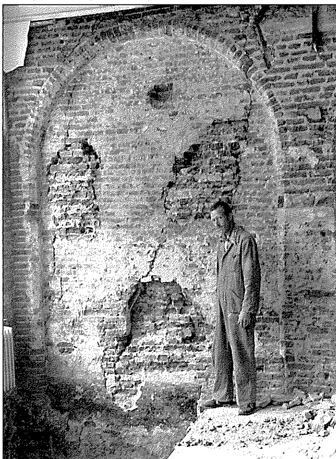
Afb. 2-3: spaarnissen in de noordelijke muur van het huis 'den Spiegel'. In de lisenen ziet men de resten van de weggekapte uitkragende consoles waarop de muurstijlen rustten (foto's auteur)
