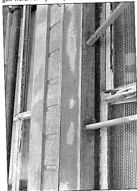
Om de vensteromlijstingen opnieuw scherp en recht te zetten werd de restauratiemortel verwerkt tussen een bekisting, die na het opdrogen werd verwijderd (foto B.M.L.)
