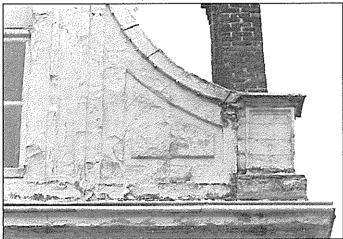
Detail van de gevelbekroning. Toestand vóór en na restauratie met steenpasta (foto H. Davans en B.M.L.)
