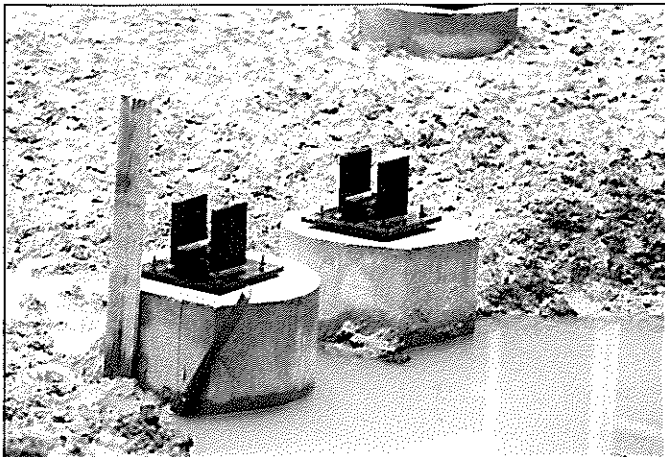
Detail van de funderingskop met metalen schoen.
