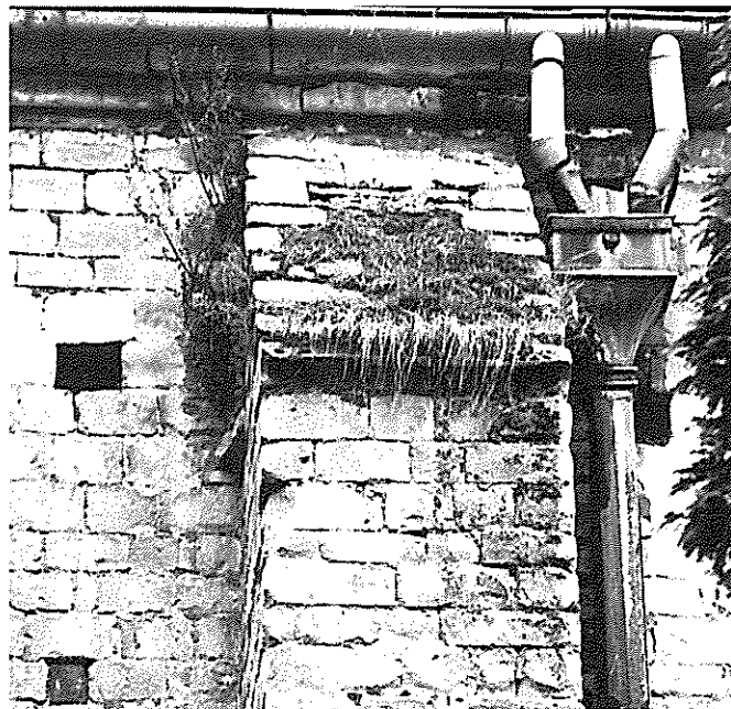
Detail van het parement, toestand 1979 (foto Building).
