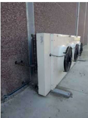
Afbeelding 27. Circulatiepomp (binnen) condensor (buiten)
