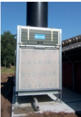
Afbeelding 19. Warmtewisselaar
