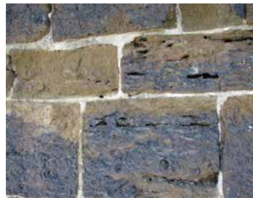
Fig. 2: Diestiaan ijzerzandsteen met donkere oppervlakte korst en duidelijke oppervlakte verwerking (Cnudde et al., 2011).
