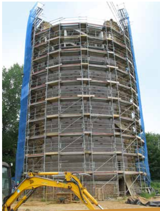
Zichem, Maagdentoren 2014. Nieuw gevelmetselwerk met Kolombasteen in de instortingszone. Foto Hilde Thibaut
