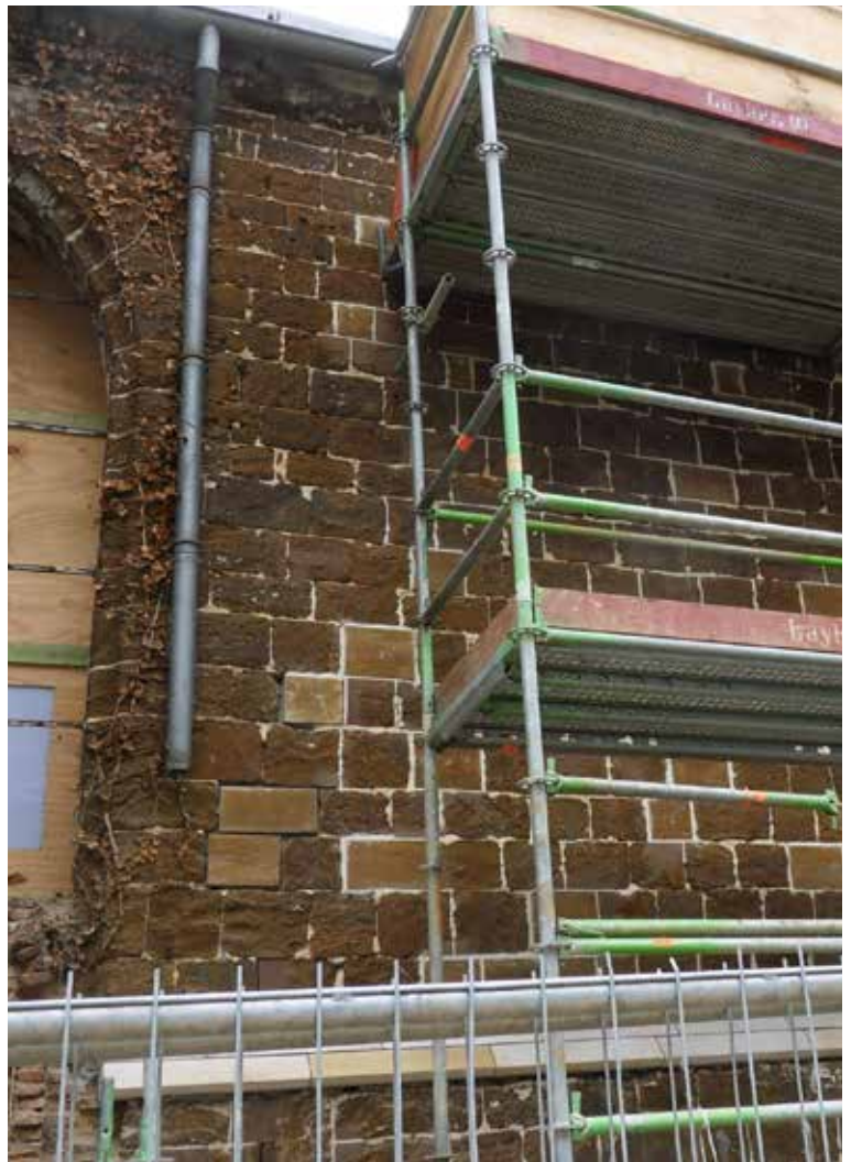
Diest, Sint-Catharinakerk. Bepaalde invulling met nieuwe ijzerzandsteen. Foto Cecile Boes
