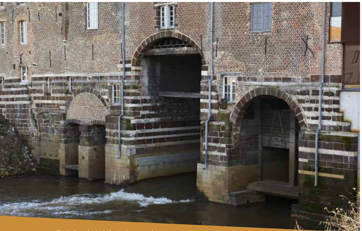
Fig. 4: Aarschot, de 's-Hertogenmolens. De onderbouw en de pijlers bestaan nog gedeeltelijk uit ijzerzandsteen.
