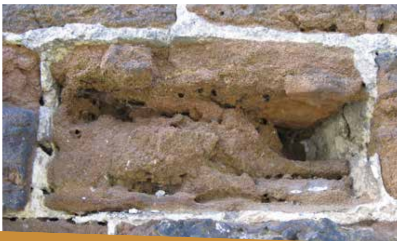
Zichem, Maagdentoren. Kenmerkende verwerking van Diestiaan ijzerzandsteen. Foto Hilde Thibaut
