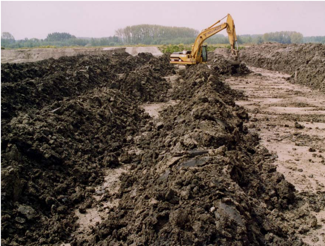
Figuur 1: Laguneringsveld, de specie wordt op ruggen gezet om de ontwatering te bevorderen.
