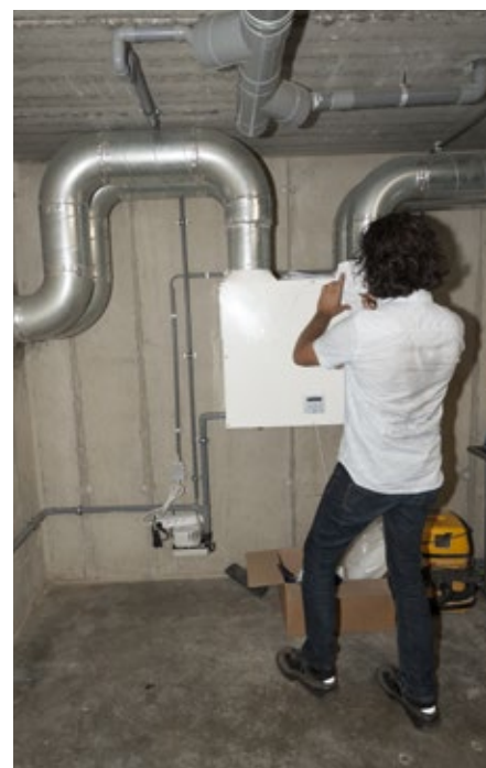
De keurder checkt alle leidingen en de bouwplannen.
