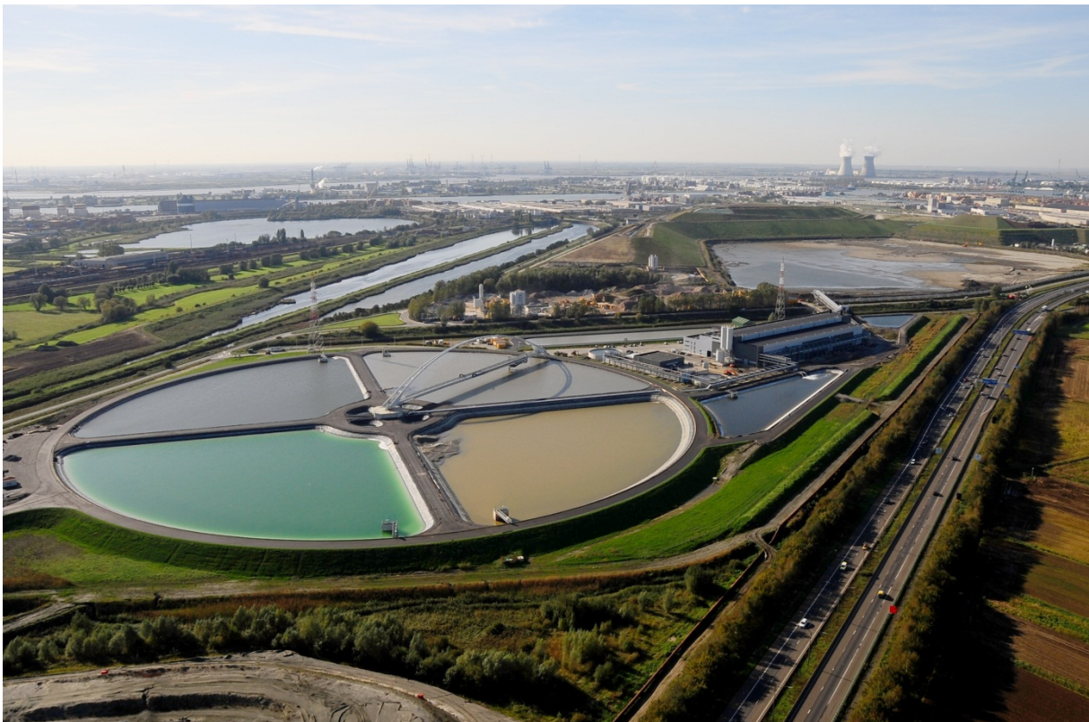
Figuur 7-15: luchtfoto van de AMORAS-installatie
