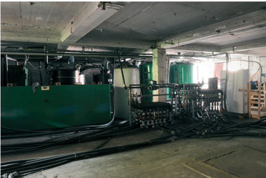
De bodemsaneringswerken zelf © OVAM.
