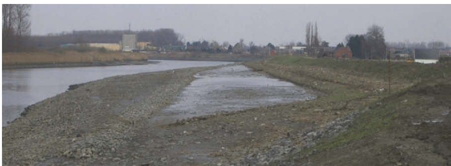
Figuur 2-6. Dijkherlegging aan Paddebeek met alternatieve verdediging van het dijklichaam met perkoenpalen en wilgenteenbussels. De helling van het nieuwe slik en schorgebied is verdedigd met restanten van het oude dijklichaam (maart 2004).
