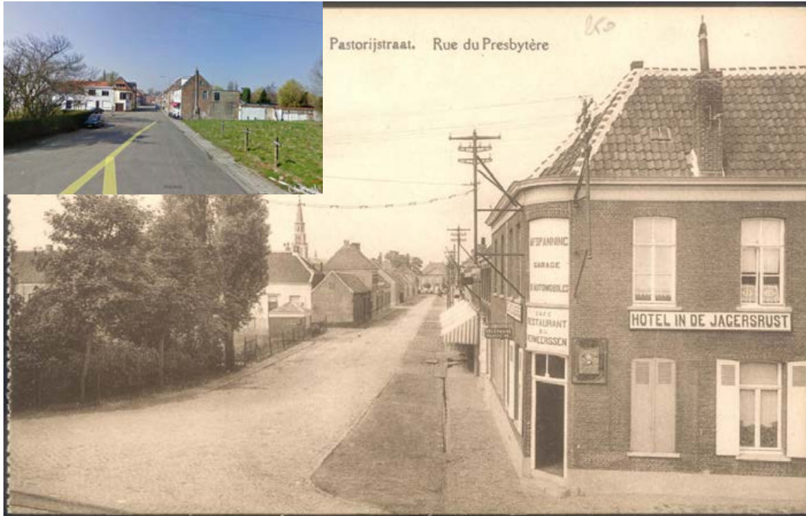
Figuur 31: Zicht op de Pastorijsstraat te Doel (ongedateerd, http://www.waaserfgoed.be/collectie/14-bladeren-gemeente/11-doen-beveren-waas/6128-pastorijsstraat-doen , geraadpleegd op 5 augustus 2014). Inzet: vergelijkbare foto huidige toestand (Google Street View, geraadpleegd op 5 augustus 2014).
