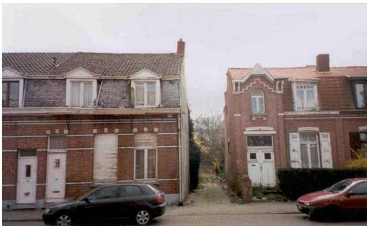
Gesloopte gebouwen - nummers 66 en 64 (links) en nummer 62 (rechts) Christiaan Pallemansstraat te Kapellen
