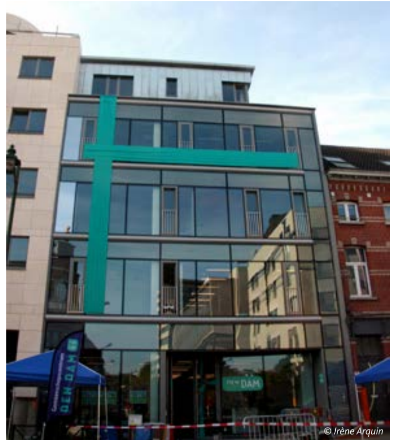
De nieuwe voorgevel spiegelt de straat letterlijk naar binnen.
