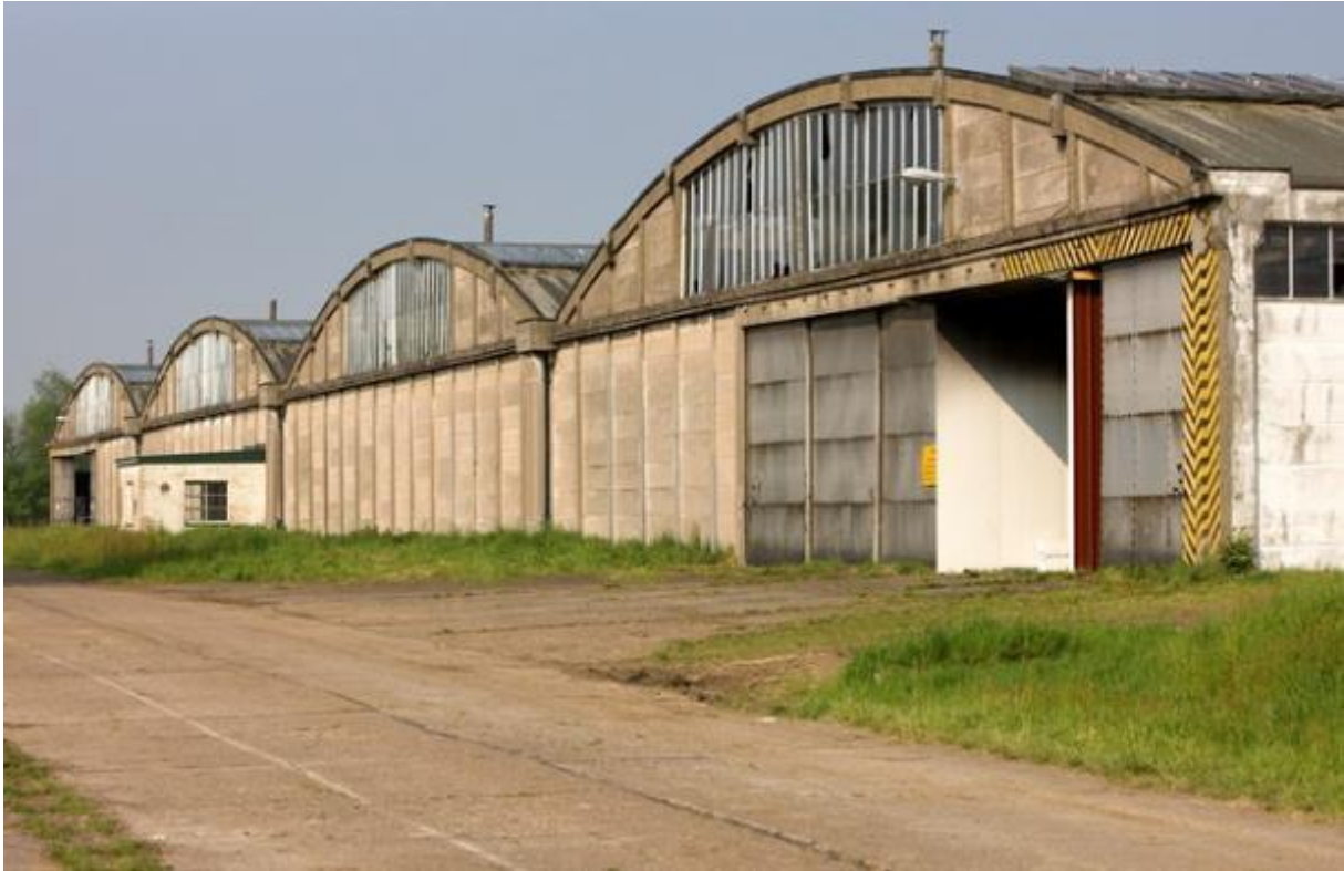
Figuur Campus Vesta 1_Referentiebeeld: De her te bestemmen betonnen loods op Campus Vesta (circa 1958). ©Provincie Antwerpen, Foto's aanbesteding, 2014.
