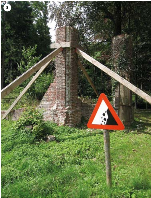
FIG. 121 Kasteel Rumbeke: a) de toegangspoort van de moestuin tijdens de restauratie; b) de toegangspoort van de moestuin na de restauratie (foto's: Koen Himpe).
