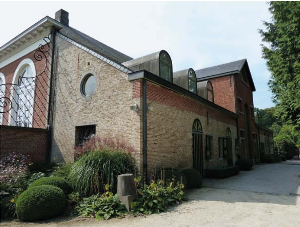
FIG. 97 De oranjerie van domein Vordenstein (stallingen aan de noordzijde) (foto: Willem Hulstaert).
