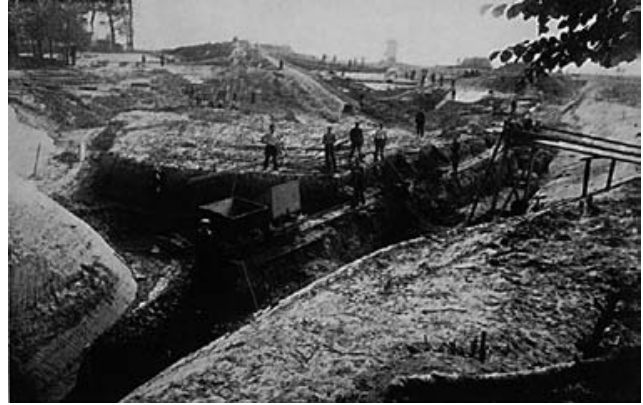
FIG. 2 Bij de aanleg van kasteel Allaert in Aalbeke werd een smalspoor met kiepwagentjes gebruikt ('Aalbeke in oude prentkaarten', Uitgave Davidsfonds Aalbeke, 1990, Zaltbommel NL).
