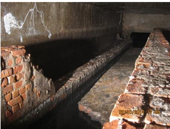
figuur 6: De ingestorte overstortmuur onder het slachthuis van Geel.
