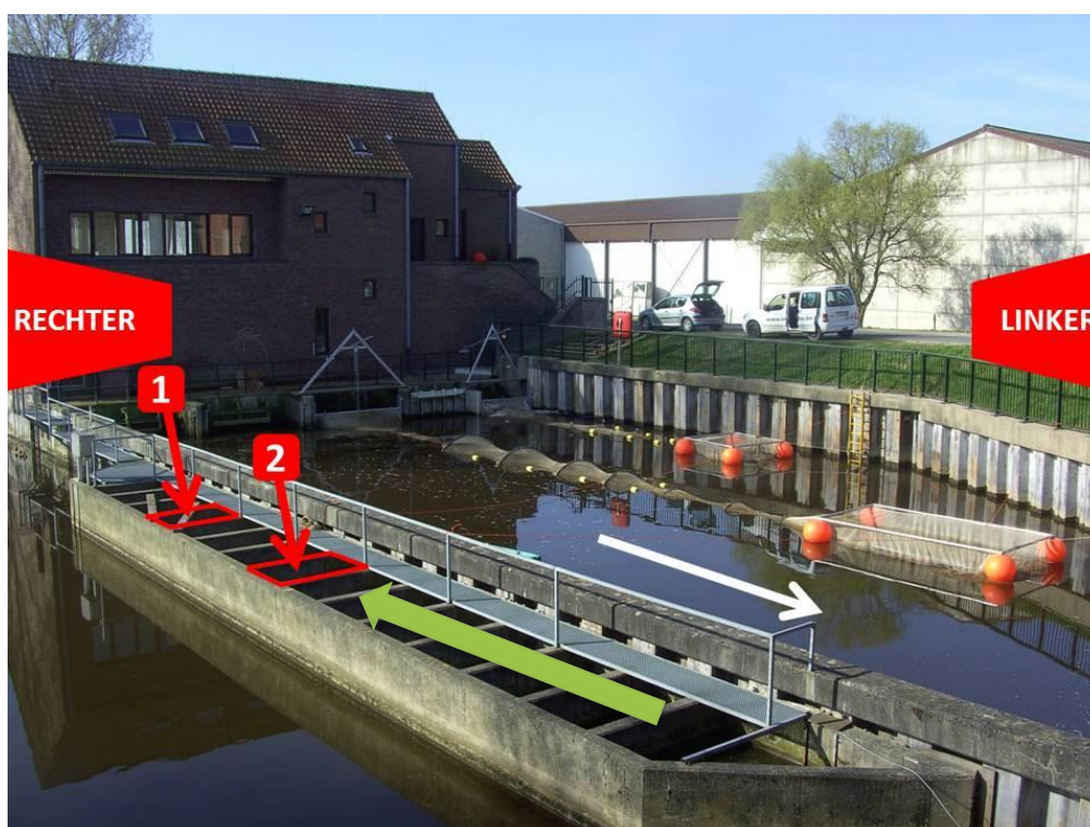
Figuur 5: De bekens van 'de Wit' visdoorgang waarin de vangkooi werd geplaatst. de witte pijl duidt de stroomrichting aan van het verpompte water; de groene pijl duidt de stroomrichting aan in de visdoorgang; RECHTER = rechteroever; LINKER = linkeroever; 1= vangkooi langs polderzijde; 2 = vangkooi langs zeezijde.
