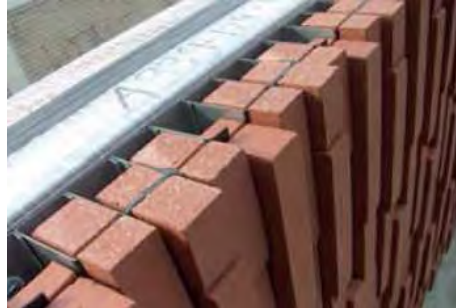
Prefabricatie van bouwcomponenten: gevelbekleding
