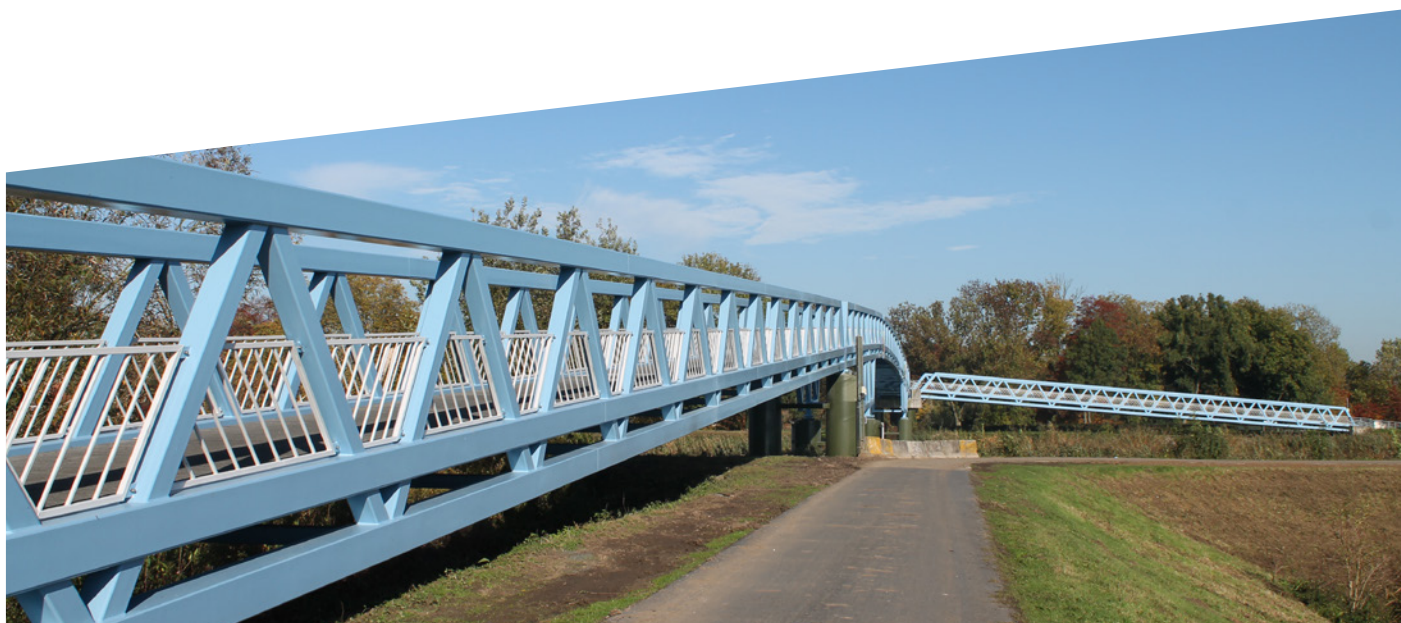
Renovatie voetgangers- en fietsersbrug over Beneden-Nete
