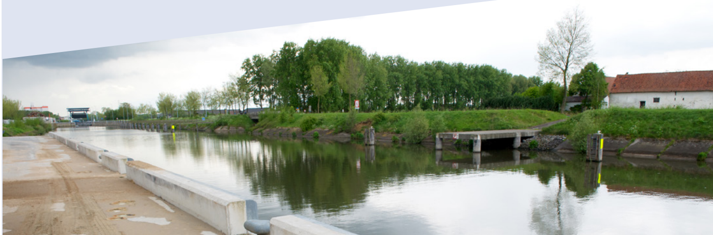
Kaaimuurproject De Meesterbeton St-Baafsvijve
