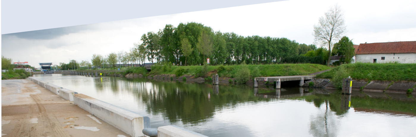
Kaaimuurproject De Meesterbeton St-Baafsvijve
