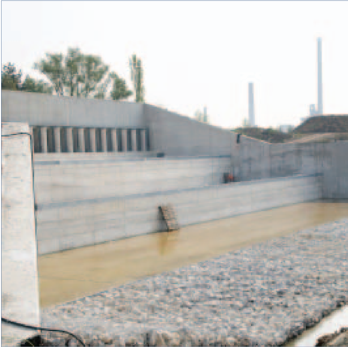
Uitwateringssluis gecontroleerd overstromingsgebied Kruibeke-Bazel-Rupelmonde
