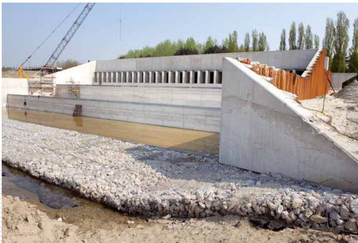
Realisatie van een uitwateringssluis in het gecontroleerd overstromingsgebied Kruibeke-Bazel-Rupelmonde
