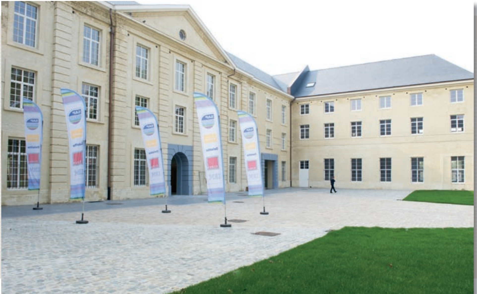
Gerestoreerde Tuchthuis als onderdeel van het project Vilvoorde Watersite aan het Zeekanaal Brussel-Schelde te Vilvoorde
