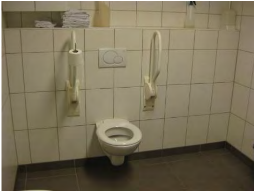
Aangepast toilet met 2 transferzijden en 2 opklapbare beugels, voorzetwand over de volledige breedte van de ruimte waardoor een beperkte zitdiepte.
