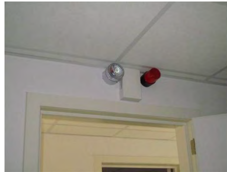
Een lichtflits die auditieve geluiden omzet in een visueel signaal (bel, een alarm, een telefoonoproep ...). KiDs vzw, © Inter
