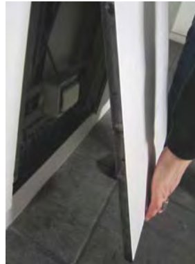
Voetbel, geplaatst ter hoogte van het toilet. Het vlak in de muur kan aangereken worden met de voetsteunen van de rolstoel. Achter de plaat zit een tuimelschakelaar verwerkt. Eigen Thuis vzw, © Inter
