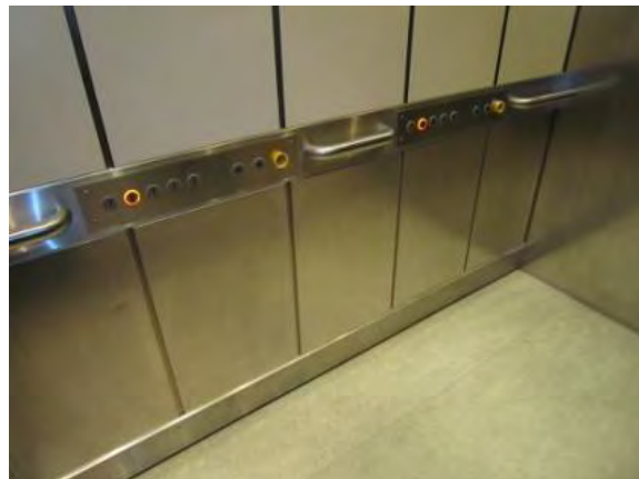
Horizontaal bedieningspaneel en handgrepen in de lift.
