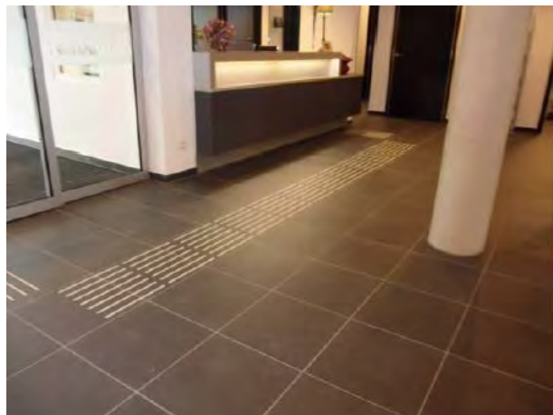
Geleiding tot aan de onthaalbalie. Woonzorgcentrum Hallenhuis, © Inter
