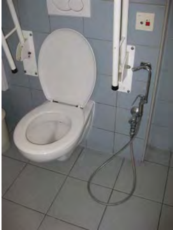
Extra kraantje met sproeier o.a. voor het uitspoelen van een urinaal. St. Lodewijk vzw, © Inter
