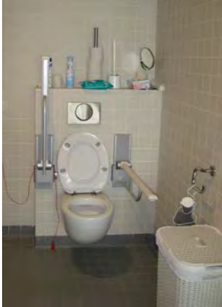
Hangtoilet met in hoogte verstelbare en opklapbare beugels. Sint-Gerardus, © Inter
