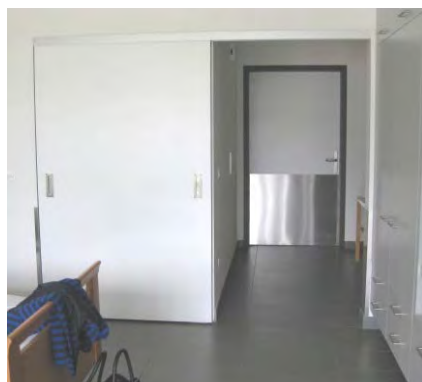
In open stand is de badkamer vlot toegankelijk en wordt de inkomhal afgesloten om de privacy te verzekeren. De schuifdeur heeft aan twee zijden een ingebouwde greep. Er kan een opbouwgreep worden geplaatst als de bewoner dat wenst. Sint-Gerardus Diepenbeek, © Inter
