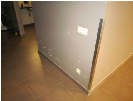
Hoekbescherming met inox hoekprofiel. Dit is niet voldoende om ook de naastgelegen wand te beschermen. Stijn vzw, © Inter
