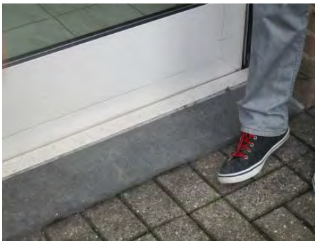
Het kleinste niveauverschil bij een overgang tussen binnen buiten zorgt voor een drempel (rolstoelgebruik). St. Lodewijk vzw, © Inter
