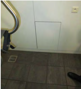
Voetbel, geplaatst ter hoogte van het toilet. Het vlak in de muur kan aangereken worden met de voetsteunen van de rolstoel. Achter de plaat zit een tuimelschakelaar verwerkt. Eigen Thuis vzw, © Inter
