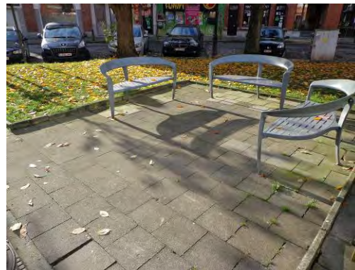
Rustpunten op een route, buiten de circulatiezone gelegen. Openbaar domein Woluwe, © Inter
