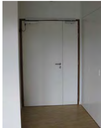
Rolstoeltoegankelijke deur met naastliggend paneel. WZC Lommel, © Inter
