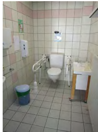
Toilet met opklapbare beugels met extra steunpoot als beveiliging tegen afbreken door neerploffen en een werkblad voor het plaatsen van verzorgingspullen. St. Lodewijk vzw, © Inter
