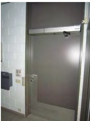
Inkomdeur met automatische deuropener bediend d.m.v. elleboogschakelaar. Mané vzw, © Inter
