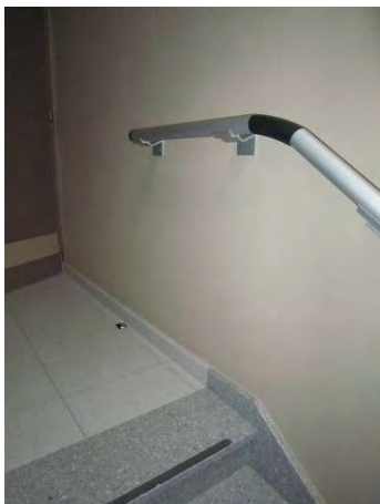
Doorlopende leuning na het einde van de trap. Zorgcentrum Maria Ter Engelen vzw, © Inter
