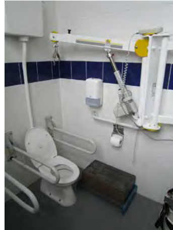
Tilhulpsysteem (wandlift) in een toilet voor jongere kinderen, met losse voetsteun op zithoogte.
