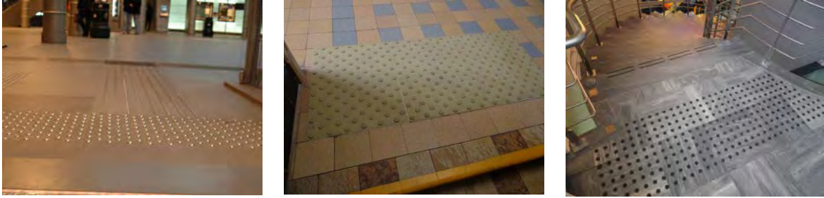
Verskillende toepassingen van hetzelfde principes kan. Bijvoorbeeld het aanbrengen van noppen in verschillende materialen: noppen in roestvast staal, verlijmd kunststof stroken en antislip noppen. Antwerpen centraal, Koninklijk Instituut Woluwe, © Inter
