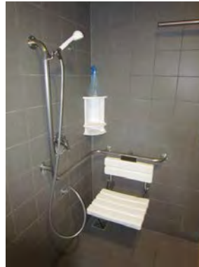
Wegneembare douchezit en hoekwandbeugel die ook als gleistang gebruikt wordt. Mané vzw, © Inter
