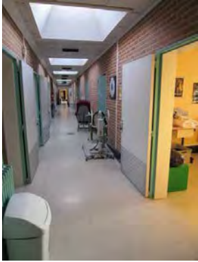
Deuren met stootboorden in staalplaat. Dominiek Savio Instituut, © Inter
