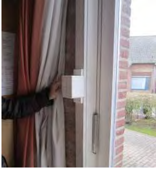
Voorbeeld van beveiliging van rolluikdrukknop in een houten kastje.
