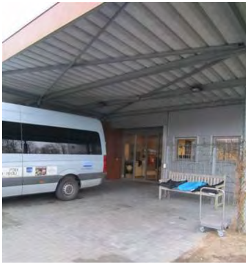
Overdekte voorrijdzone. Er is een wachtzone aanwezig voor wie toekomt of vertrek. Stijn vzw, © Inter
