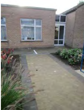
Paden zijn drempelloos en voldoende ruim. St. Lodewijk vzw, © Inter
