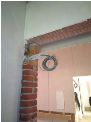
Aansluiting voor deurautomatisatie in ruwbouwfase. Dominiek Savio Instituut, © Inter
