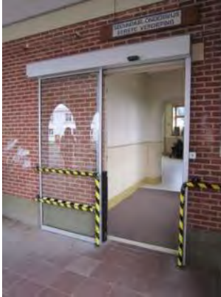
Bescherming van de glazen deur: ijzeren kader met waarschuwingsmarkering. St. Lodewijk vzw, © Inter
