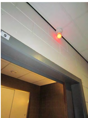
Verkliklamp wanneer het toilet in gebruik is, gekoppeld aan het licht in de toiletruimte. Mané vzw, © Inter
