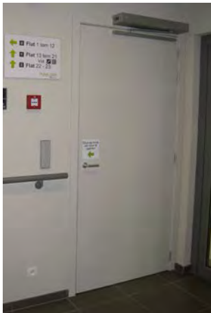
Automatische draaideur met drukknop. Woonvorm Koersel, © Inter
