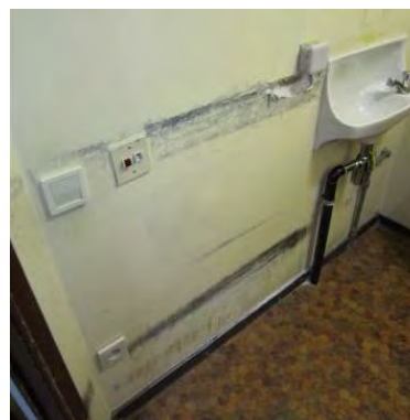
Wandbeschadiging door voetsteunen en joystick van de rolstoel. Eigen Thuis vzw, © Inter
