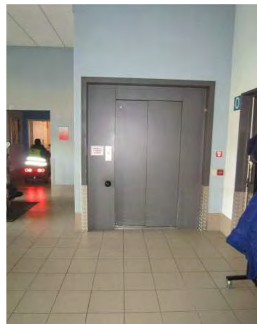
Voor de lift er is er voldoende manoeuvreerruimte aanwezig. Deze is ook volledig buiten de andere circulatiezones gelegen.
