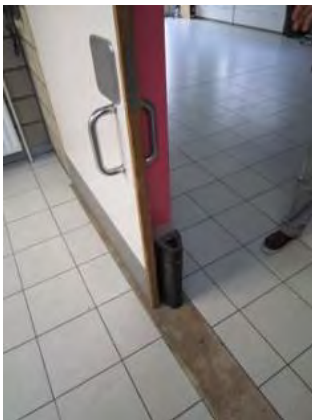
Bescherming van de deur: kunststof hoekbeschermer voor het loshangende deel. St. Lodewijk vzw, © Inter
