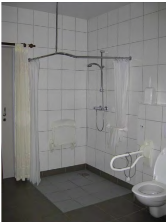
Drempelloze douchehoek met opklapbare douchezet. Stijn vzw, © Inter
