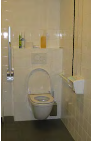
Alarmkoord in aangepast toilet. DVC De brug - Heusden-Zolder © Inter
