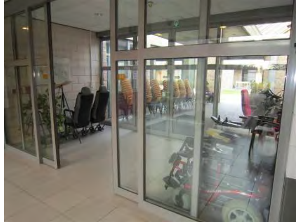
Het voordeel aan een sas met interval tussen de twee deuren is een tochtscherm. Let wel, passage voor het oog (binnen) opent de deur onnodig. Mané vzw, © Inter
