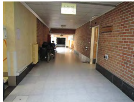
Verhoogde plint aan de muren. Hoeken met hoekprofielen in kunststof. Dominiek Savio Instituut, © Inter
