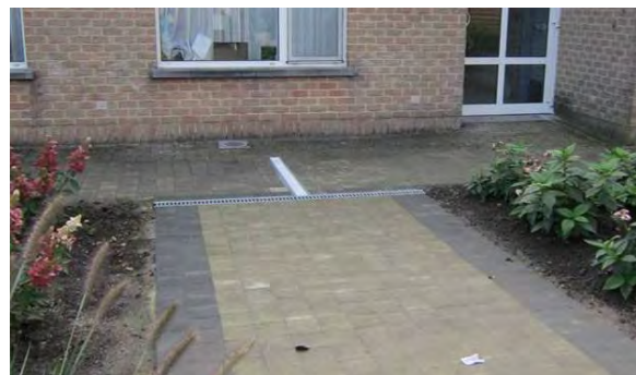
Rooster dwars op de circulatierichting. Groenaanplanting vormt een natuurlijke vorm van geleiding. St. Lodewijk vzw, © Inter
