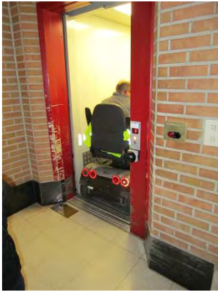
Lift type 2, basis rolstoeltoegankelijke lift. Dominiek Savio Instituut, © Inter
