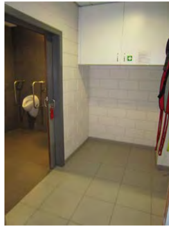
Tussenas tussen 2 ruimten doet dienst als extra transferruimte: hier blijft de rolstoel staan als er een verrijdbare tillift gebruikt wordt. Mané vzw, © Inter
