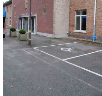
Aangepaste parkeerplaatsen aan de toegang tot het gebouw. Let wel, de signalisatie kan beter uitgewerkt worden.
