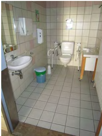
Semi-ambulant toilet. St. Lodewijk vzw, © Inter
