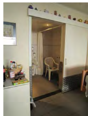
Schuifwand naar een badkamer. De schuifdeur heeft aan twee zijden een goed omgrijpbare greep in opbouw. Dominiek Savio Instituut, © Inter
