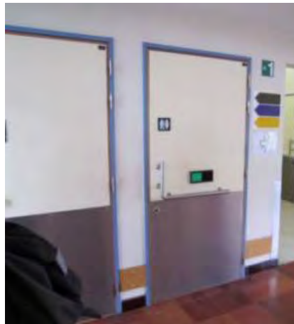
L-vormige greep aan de deur van het toilet.
