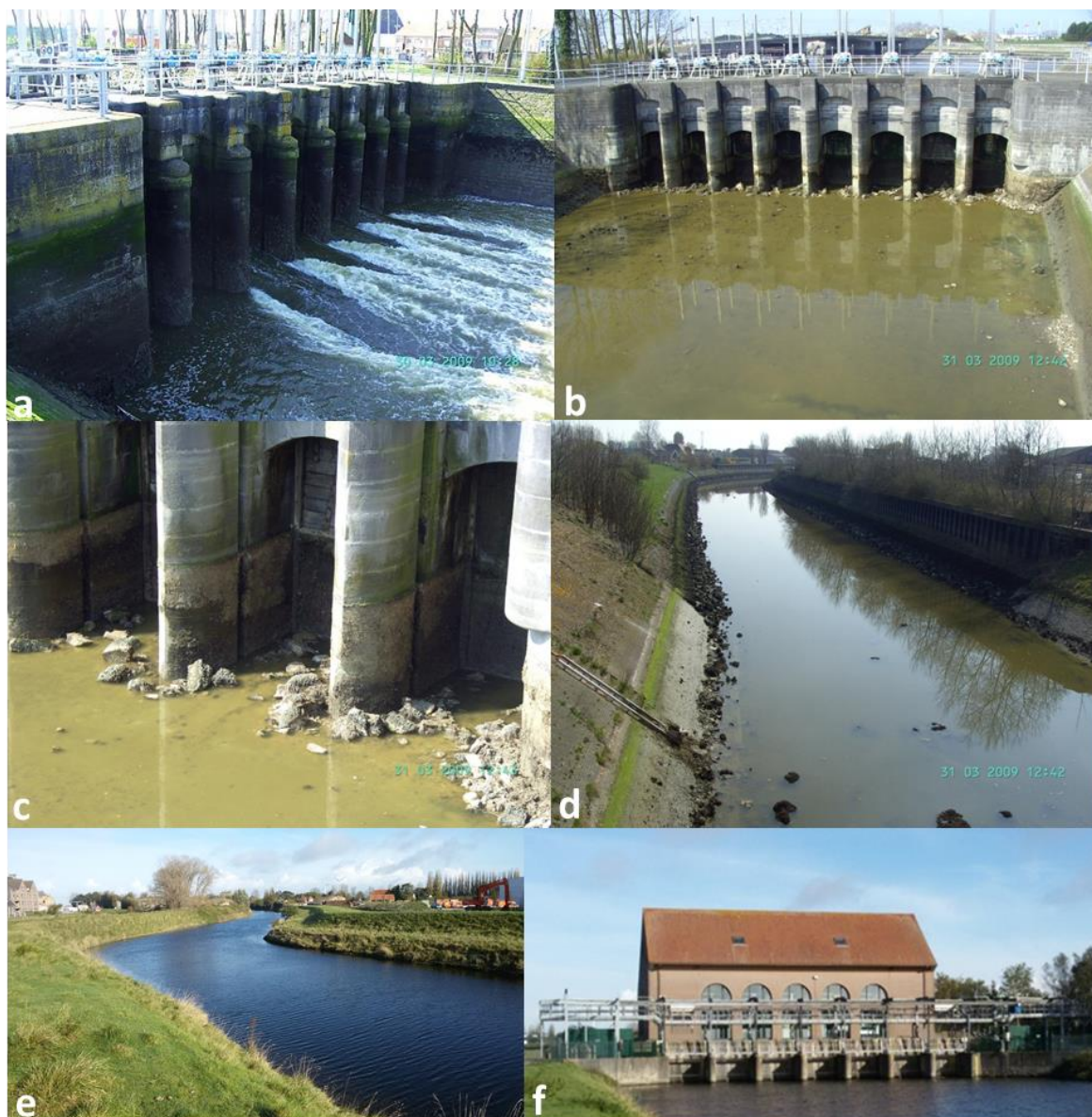
Figuur 8 Overzicht van het studiegebied met (a) de stroomafwaartse zijde van de spuiconstructie van het Afvoerkanaal Veurne-Ambacht aan de Ganzepoot tijdens laagtij waarbij polderwater wordt afgevoerd, (b-c) de stroomopwaartse zijde van de spuiconstructie tijdens springtij, (d) het Afvoerkanaal stroomopwaarts van de spuiconstructie tijdens springtij, (e) het Afvoerkanaal stroomafwaarts het pompgebouw en (f) de stroomopwaartse zijde van het pompgebouw van Veurne-Ambacht. (foto © 2009/2013 INBO)
