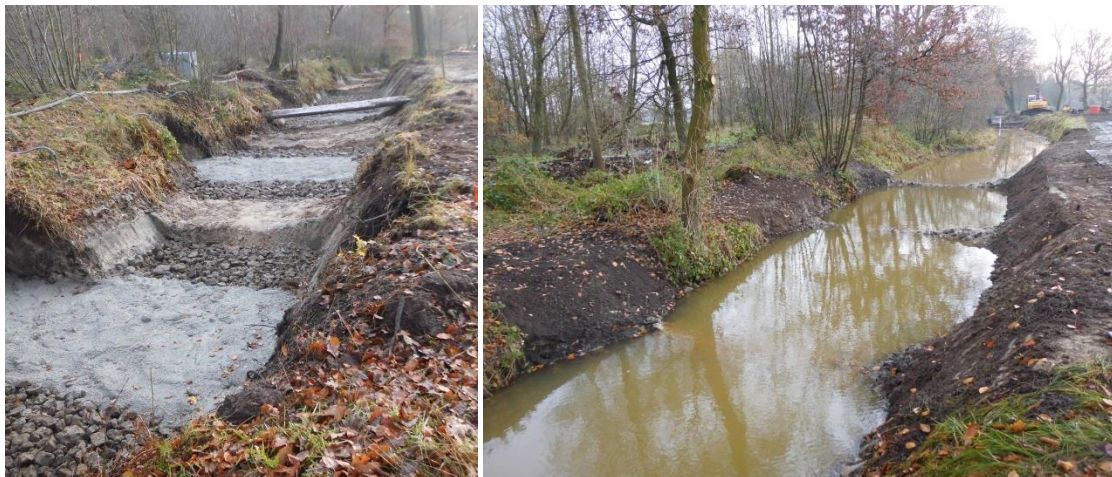
Figuur 95 Foto's genomen tijdens en na de aanleg van de vistrappen en daartussen gelegen riffles in de Dalemansloop in december 2013.
