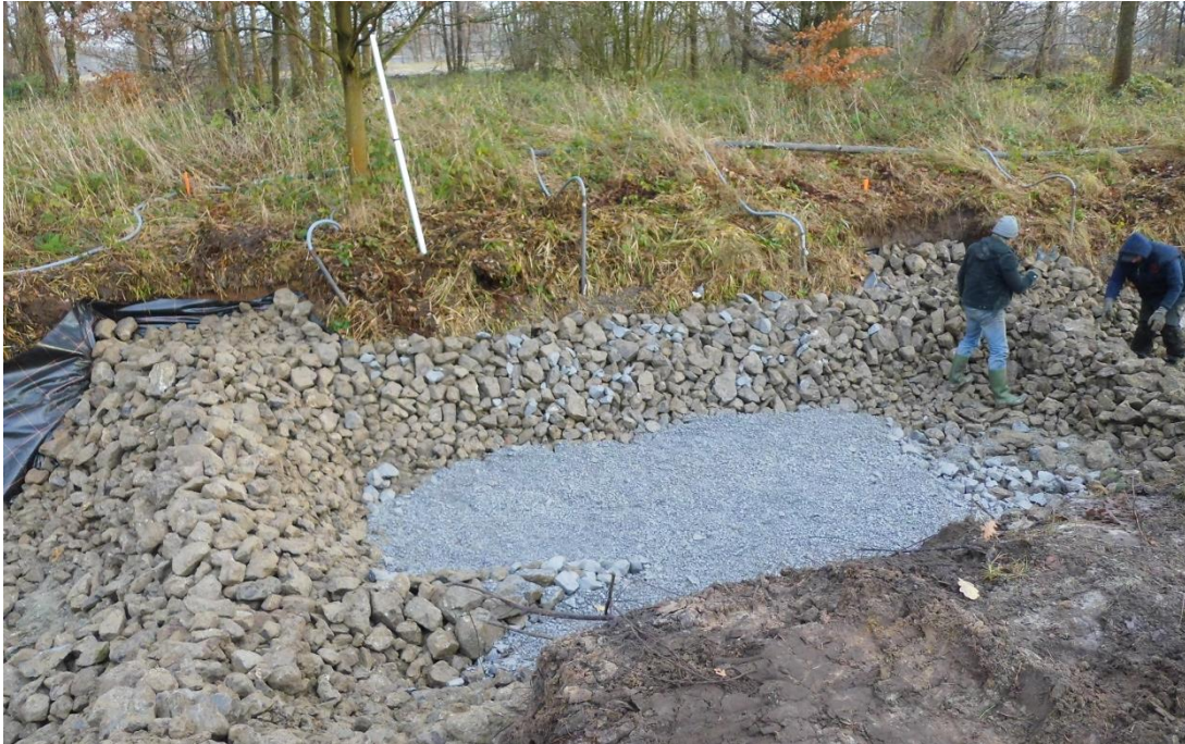
Figuur 96 Aanleg van de riffles tussen de geplaatste vistrappen in de Dalemansloop in december 2013.
