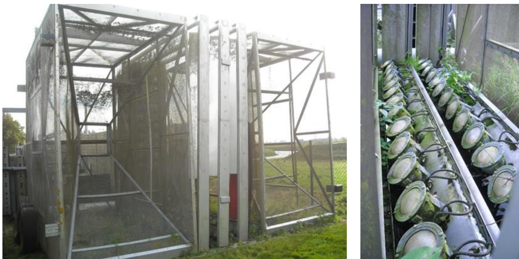
Figuur 7 Afschrik- en vangstinstallatie voor vis ontworpen voor het pompgemaal van Veurne-Ambacht (toestand anno 2015). (foto © 2015 INBO)
