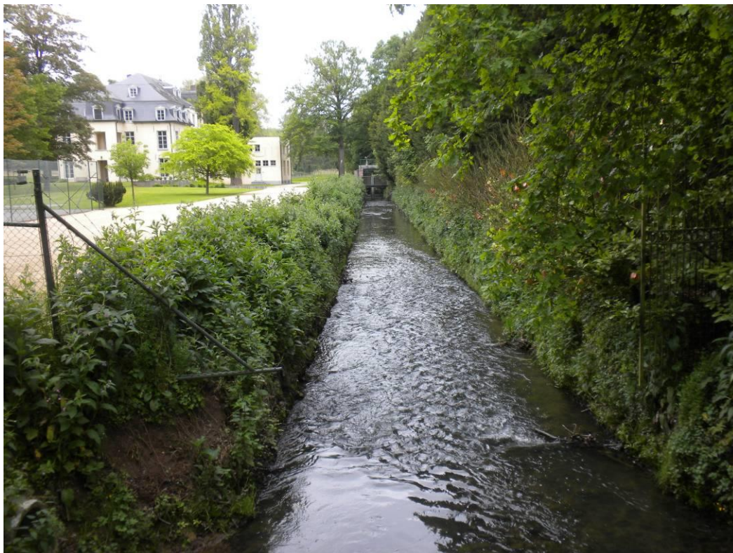
Figuur 87 De kunstmatige riffle in de IJse stroomafwaarts van de Elsenstraat (Neerijse).
