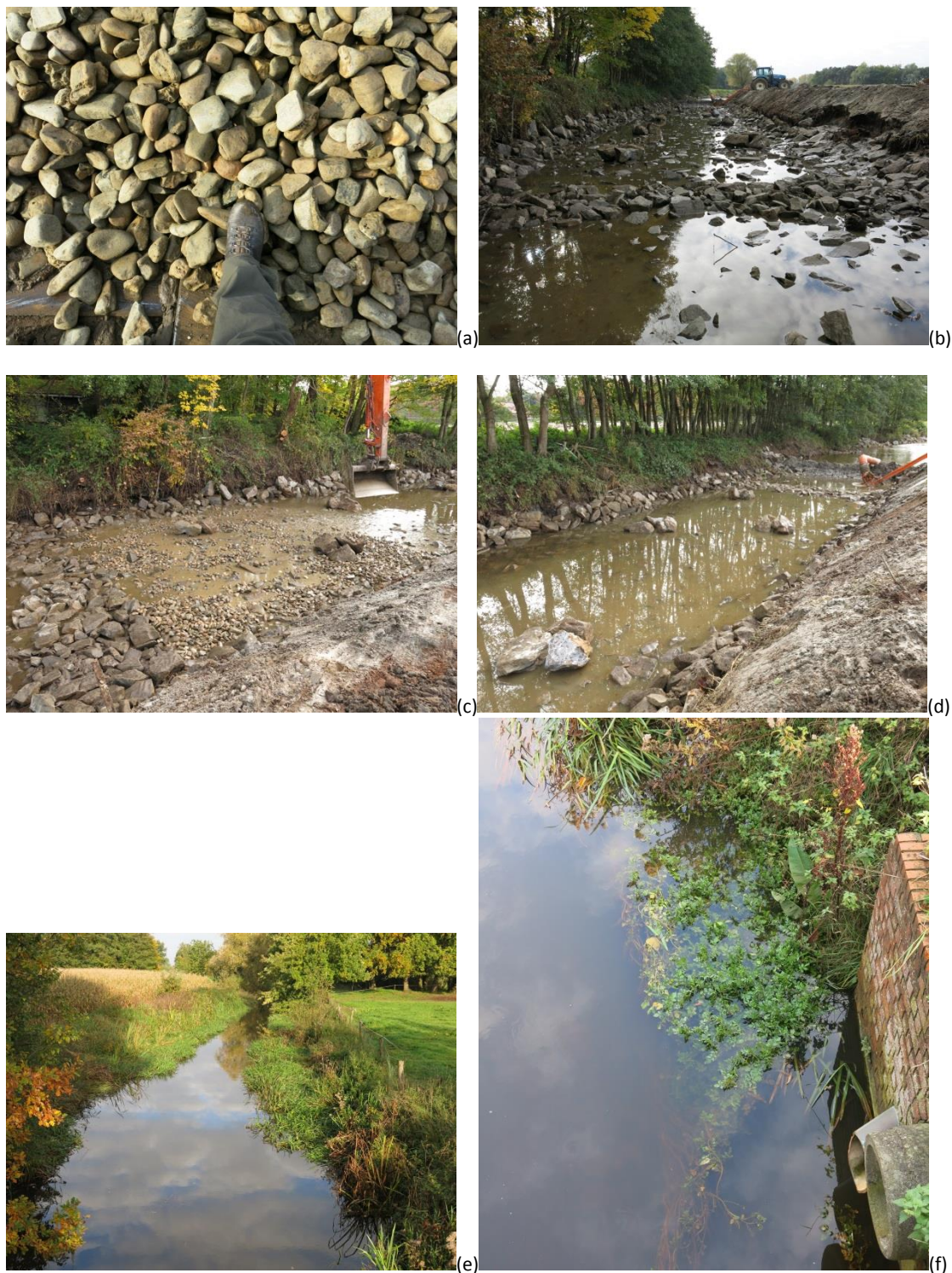
Figuur 103 Foto's genomen tijdens de aanleg van de riffle in de Wamp. (a) middelgrote stenen (80-200 mm), (b) zicht vanop de vistrap stroomopwaarts van de riffle waar vlak achter de trap een stuk ongeroerd werd gelaten, gevolgd door een iets hogere boord stenen, en daarna de riffle met de zigzag van hoopjes met 3 grote stenen bij elkaar, (c) de middelgrote stenen (80-200 mm) werden aangevoerd, (d) de riffle meer stroomafwaarts weer tevens de groepering van stenen per 3 te zien is, (e) stroomopwaarts van de riffle, (f) waterplanten stroomopwaarts van de riffle.
