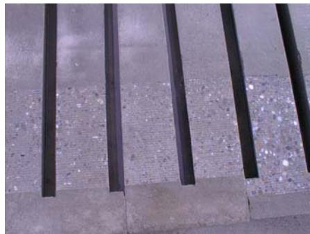
Figuur 29: opgeruwde vloer dmv diamantfrees
