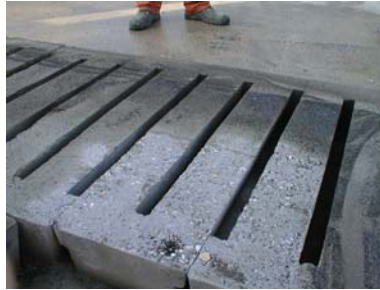
Figuur 24: Opgeruwde vloer dmv gritstralen
