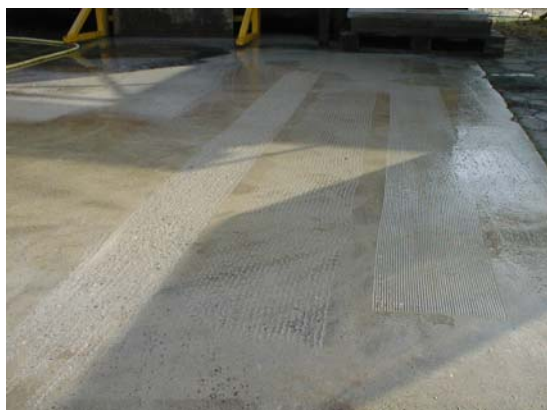
Figuur 30: Links: boucharderen; midden: lamelfrees; rechts: diamantfrees
