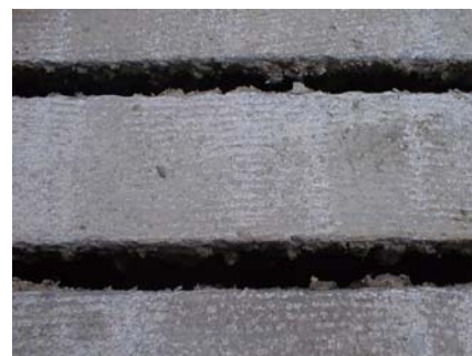
Figuur 26: opgeruwde vloer dmv lamelfrees
