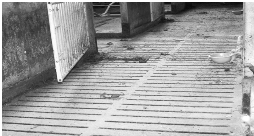
Figuur 22: Roostervloeren moeten bestand zijn tegen het agressief milieu
