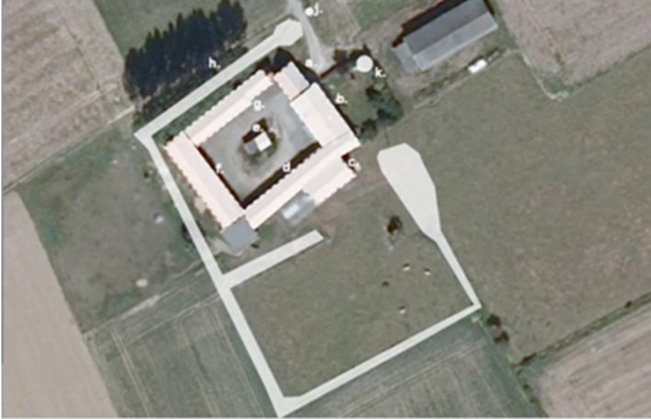
Figuur 29 - aanduiding elementen met erfgoedwaarde op luchtfoto 2009 (bron: geopunt.be, maart 2016)
