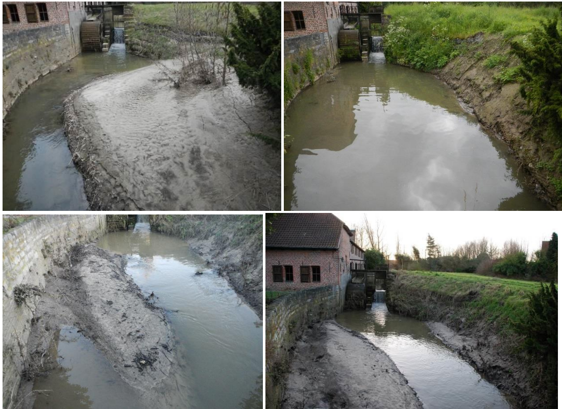
Figuur 3-46 Variabele geometrie van de woelkom aan de Borgmolen: 26/03/2013 (linksboven) en 03/06/2013 (rechtsboven), 27/12/2013 (linksonder) en 05/02/2014 (rechtsonder)
